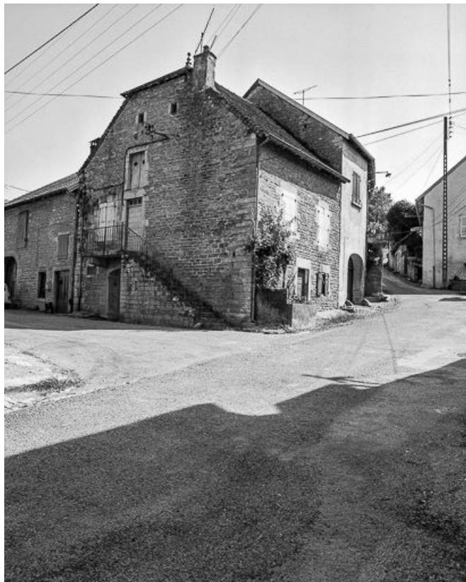
Façades antérieure et latérale gauche
