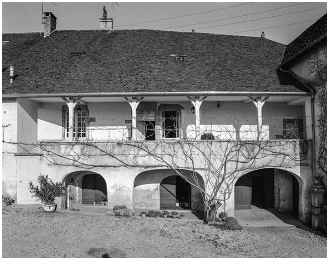
Façade antérieure vue de face.
