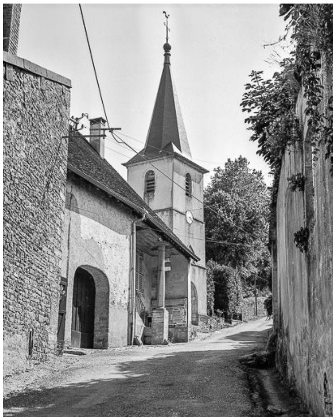
Façade antérieure : vue d'ensemble de trois quarts.
