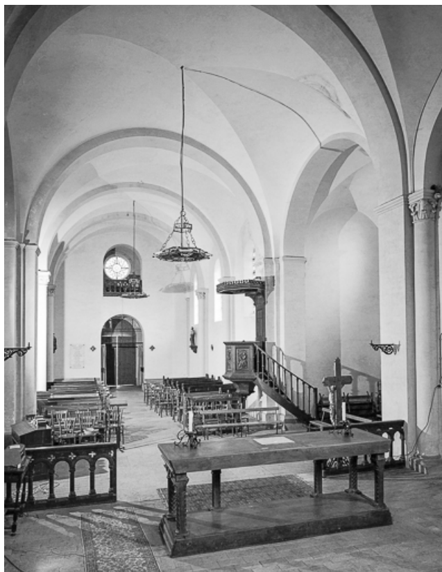
Nef vue depuis le chœur.
