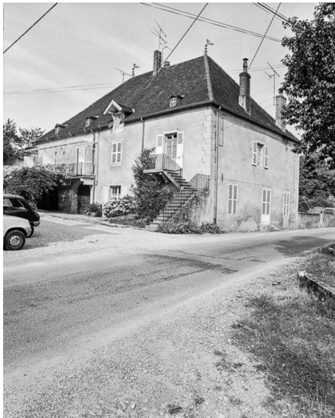
Façades antérieure et latérale droite.
