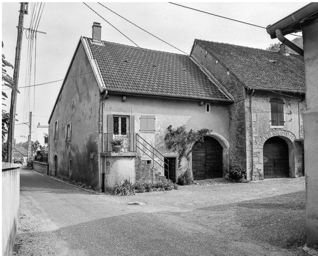
Façades antérieures et latérale gauche.
