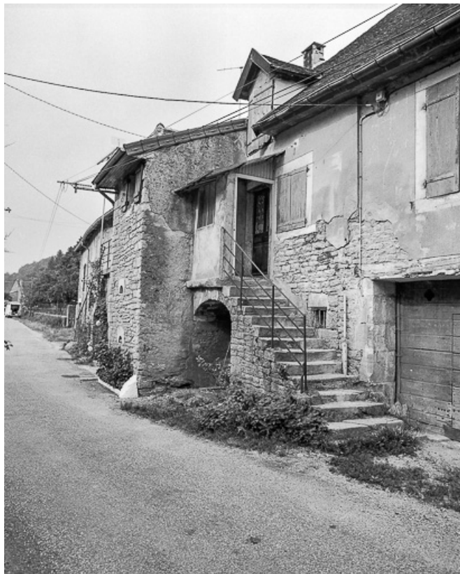
Façade antérieure : escalier à droite de l'avancée.
