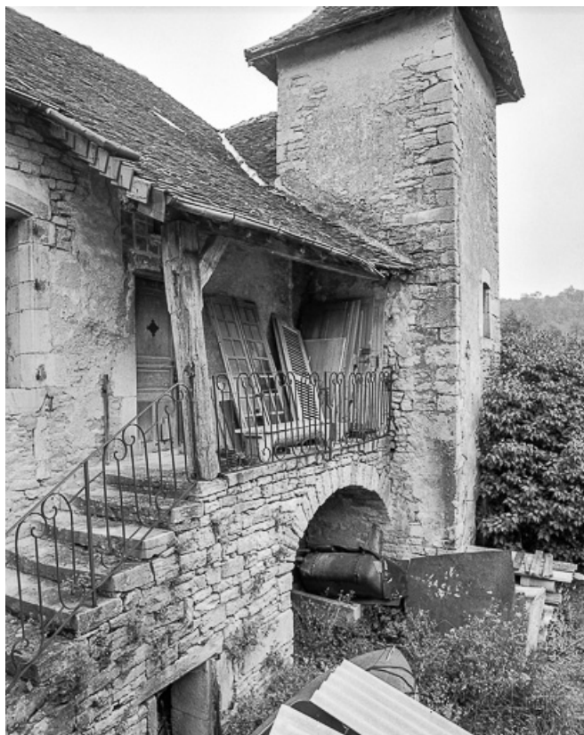
Auvent protégeant l'escalier.
