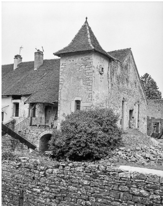
Vue de la tourelle.
