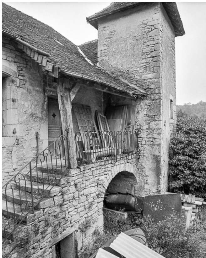
Auvent protégeant l'escalier.
