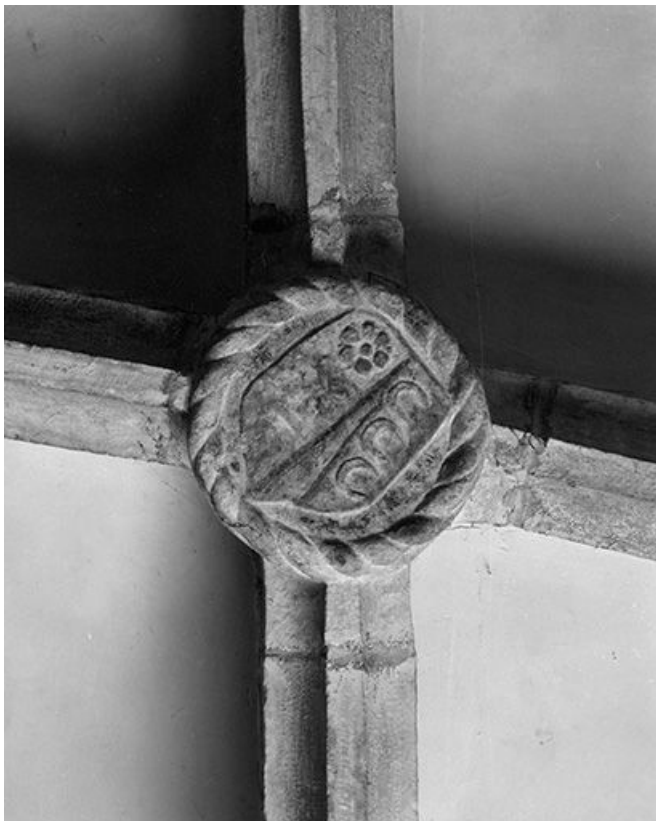
Chapelle gauche : clef de voûte.
