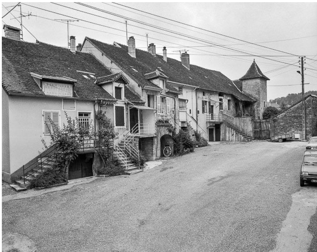
Maisons situées rue des Micholettes : façades antérieures.
