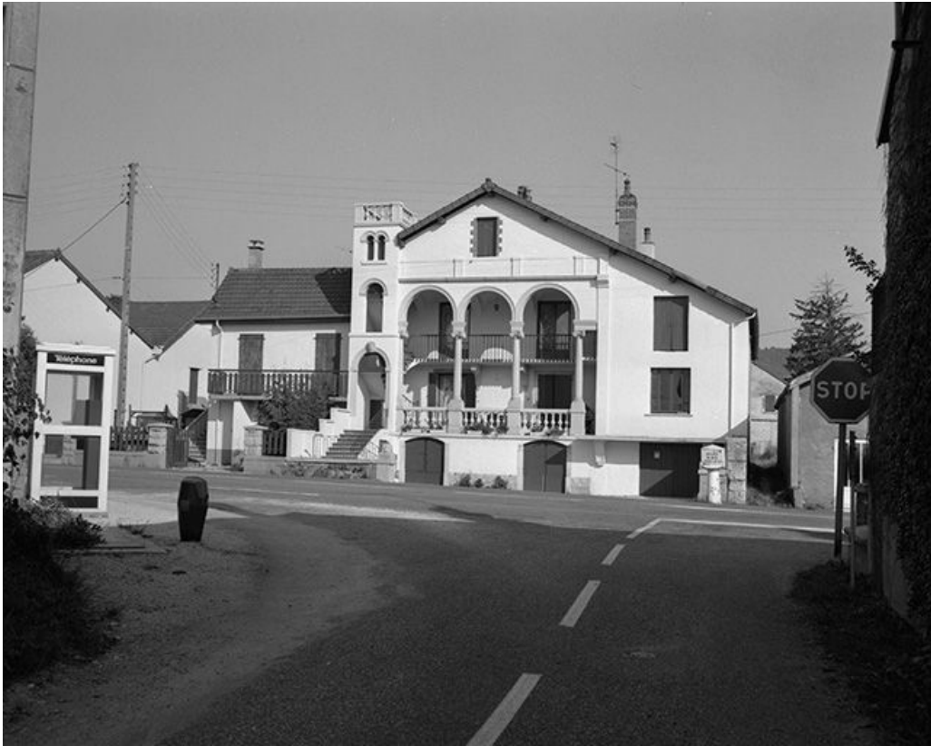
Façade antérieure vue de face.
