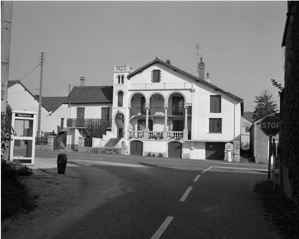
Façade antérieure vue de face.
