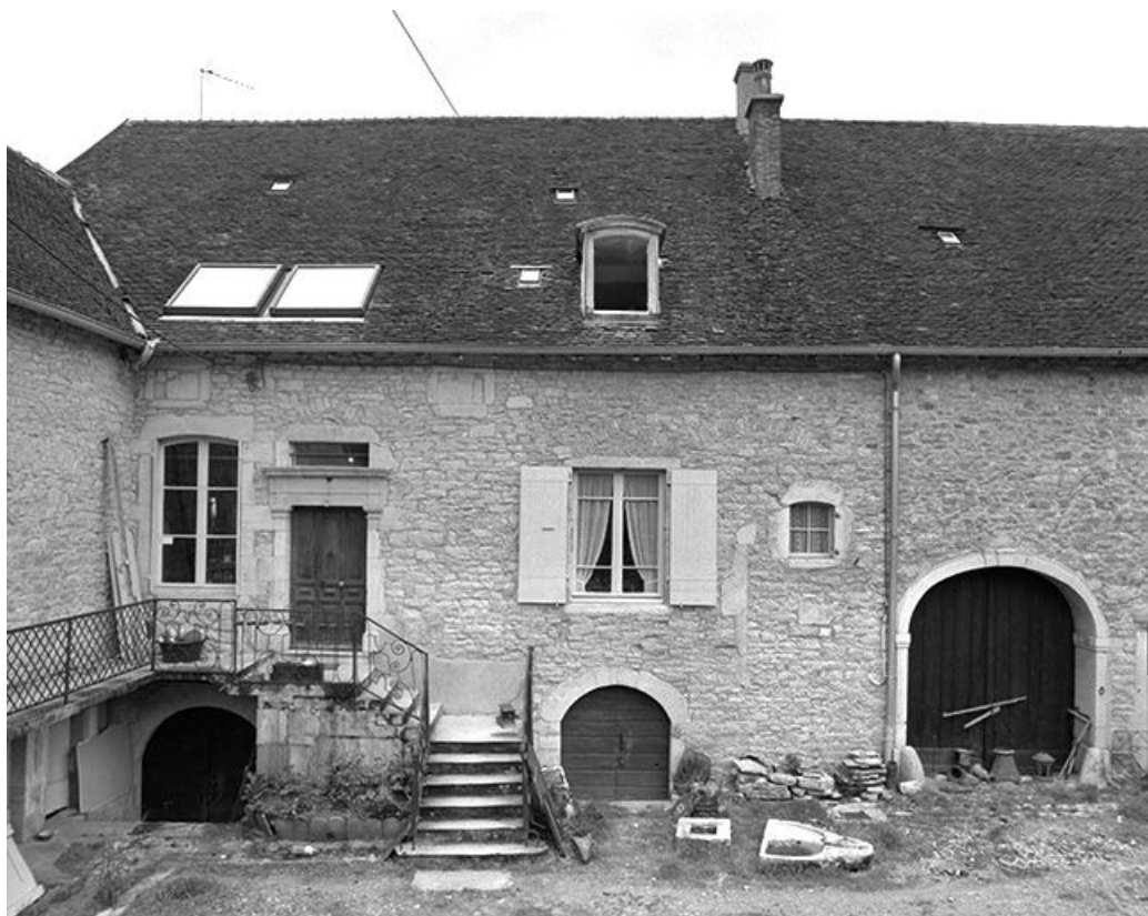
Façade antérieure, partie gauche.
