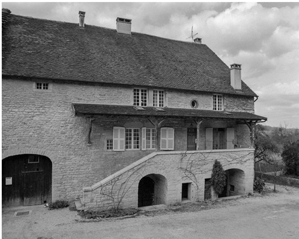
Façade antérieure de l'habitation.
