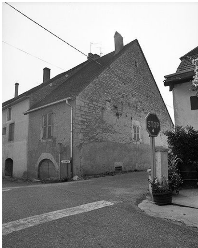
Face postérieure et pignon gauche.
