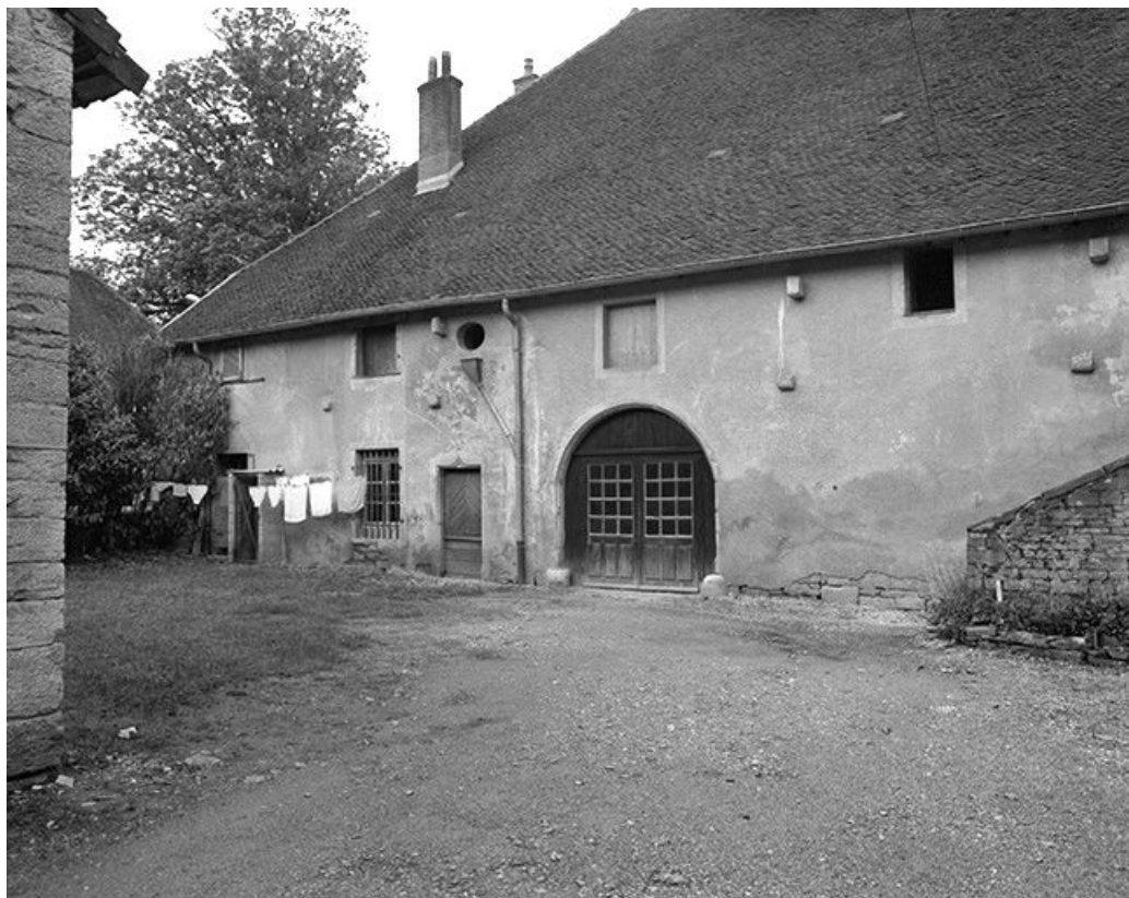
Façade antérieure, partie gauche.
