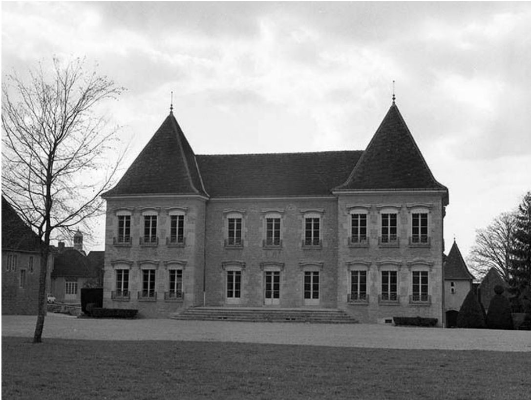
Corps du logis principal, façade principale.
