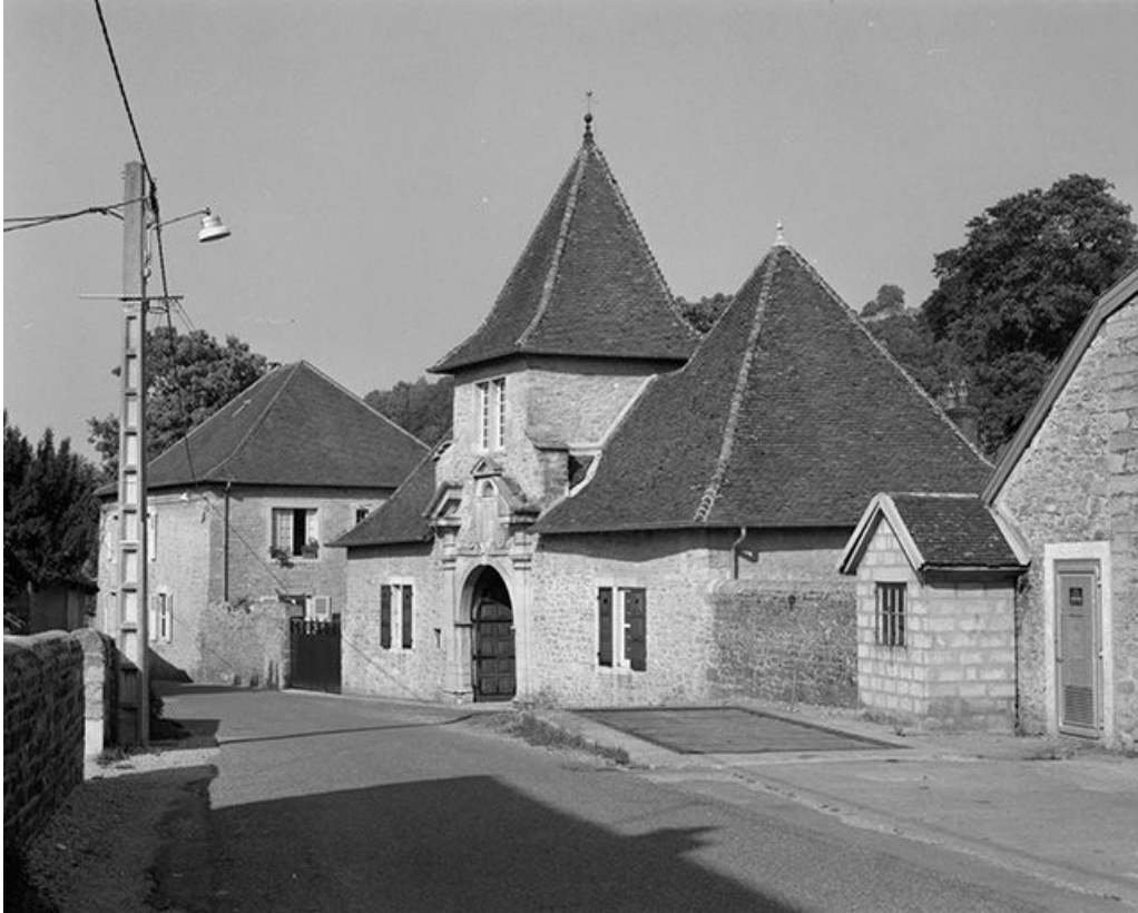
Pavillon d'entrée, élévation sur la rue.
