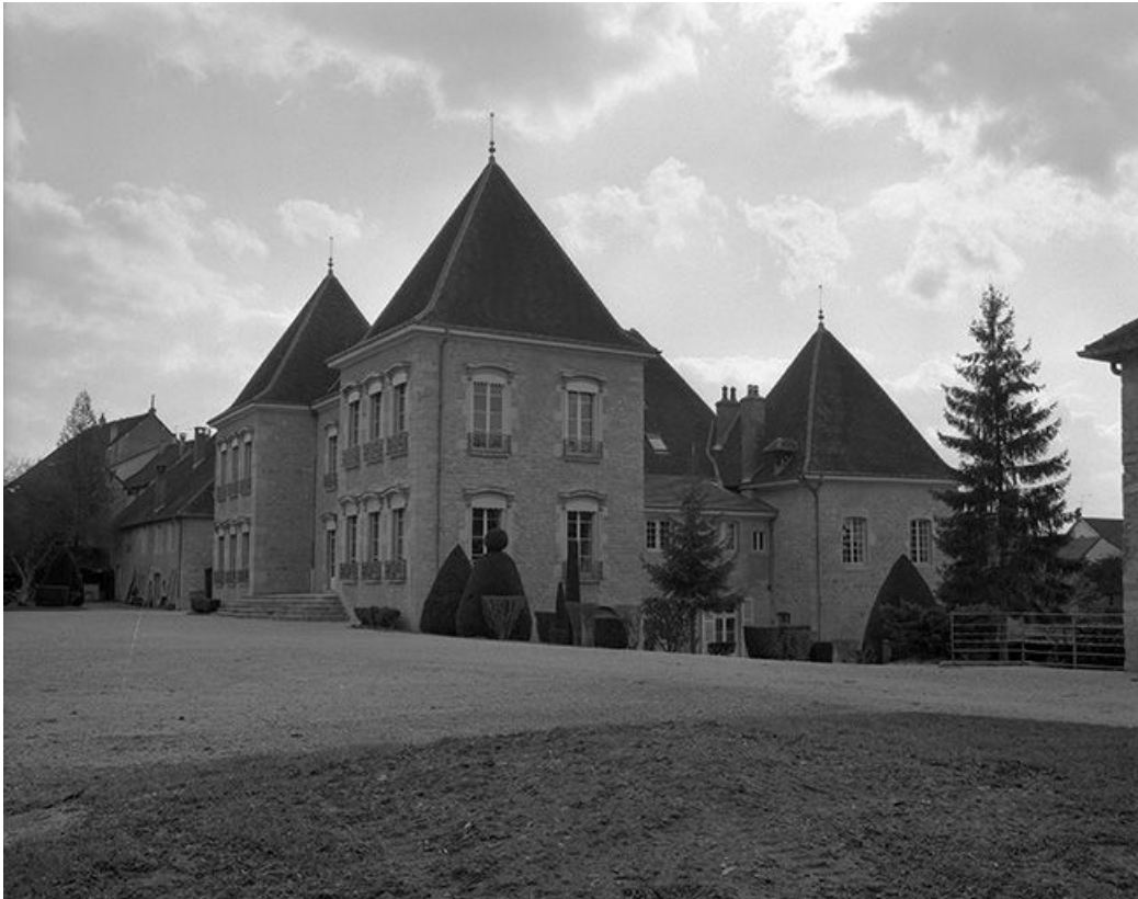
Corps du logis principal, façade principale et face gauche.
