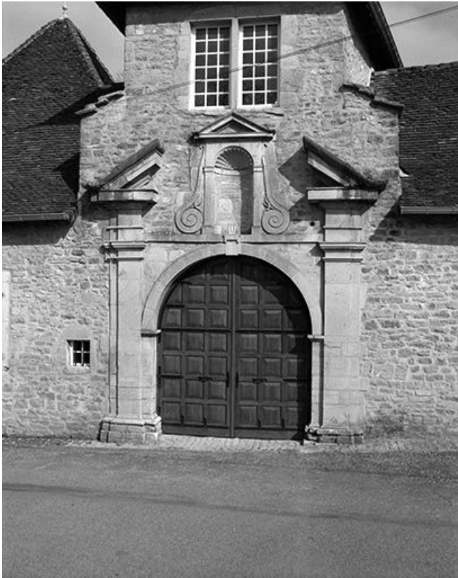
Pavillon d'entrée, le portail.
