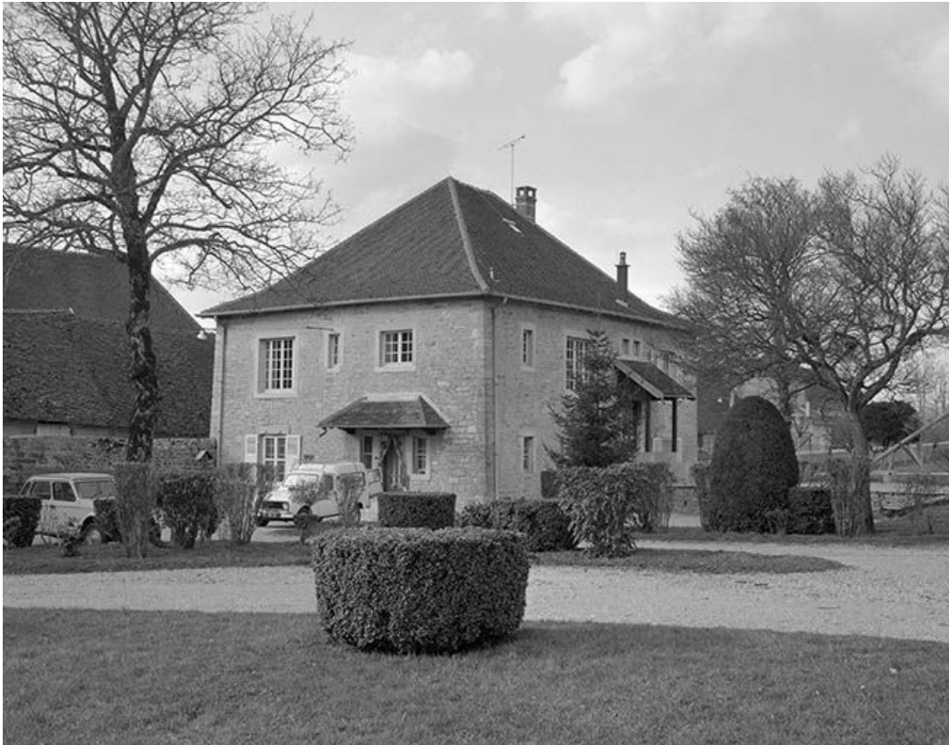
Ancienne grange, actuellement logement du gardien et infirmerie.
