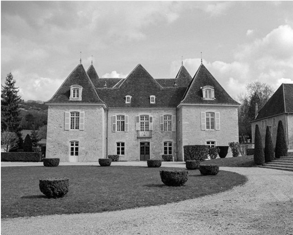
Corps du logis principal, façade antérieure.
