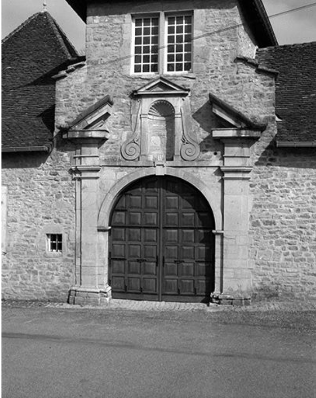
Pavillon d'entrée, le portail.
