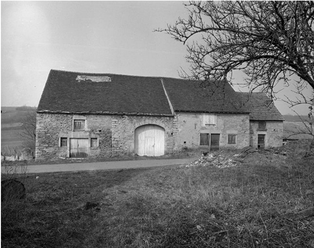
Façade antérieure, vue de face.
