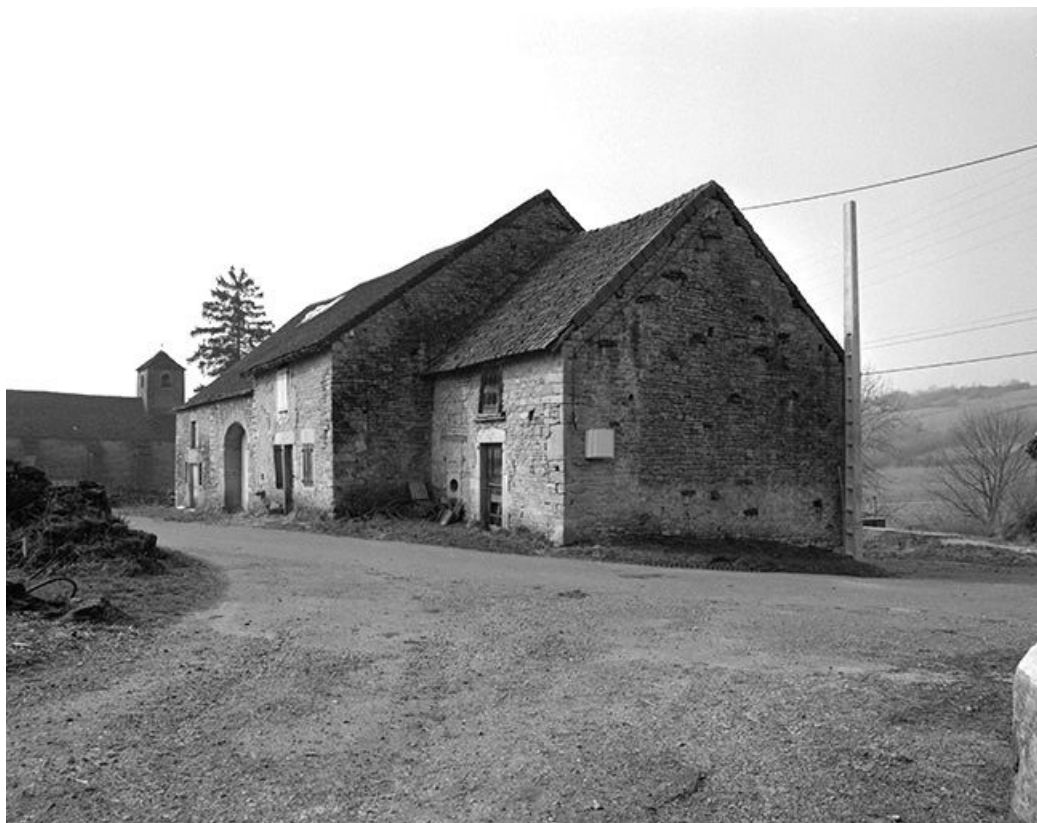
Façade antérieure et pignon droit.
