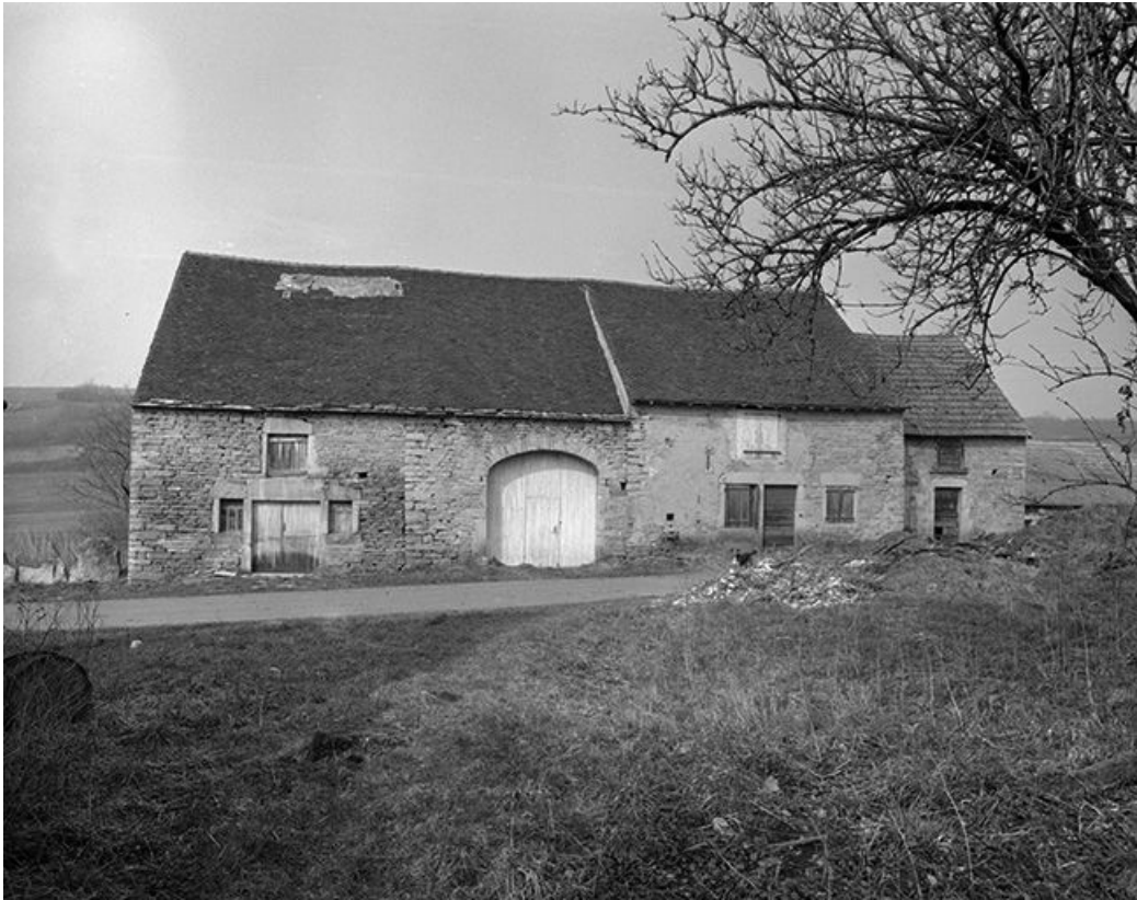
Façade antérieure, vue de face.
