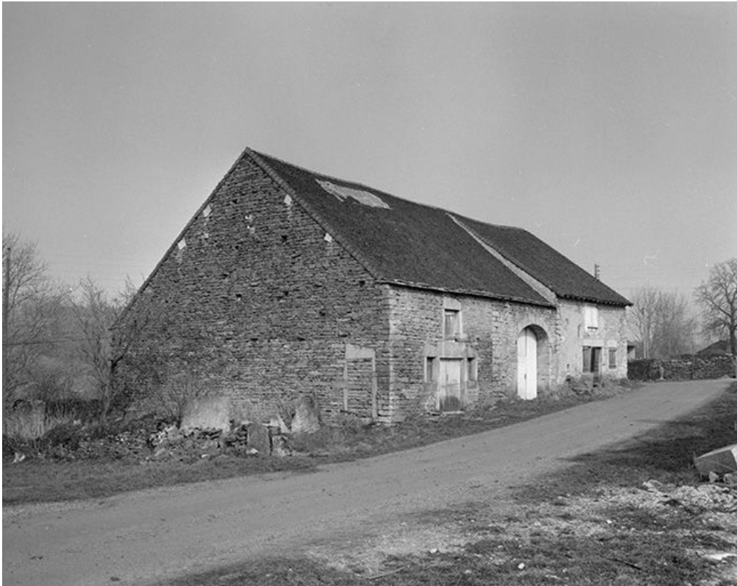
Façade antérieure et pignon gauche.
