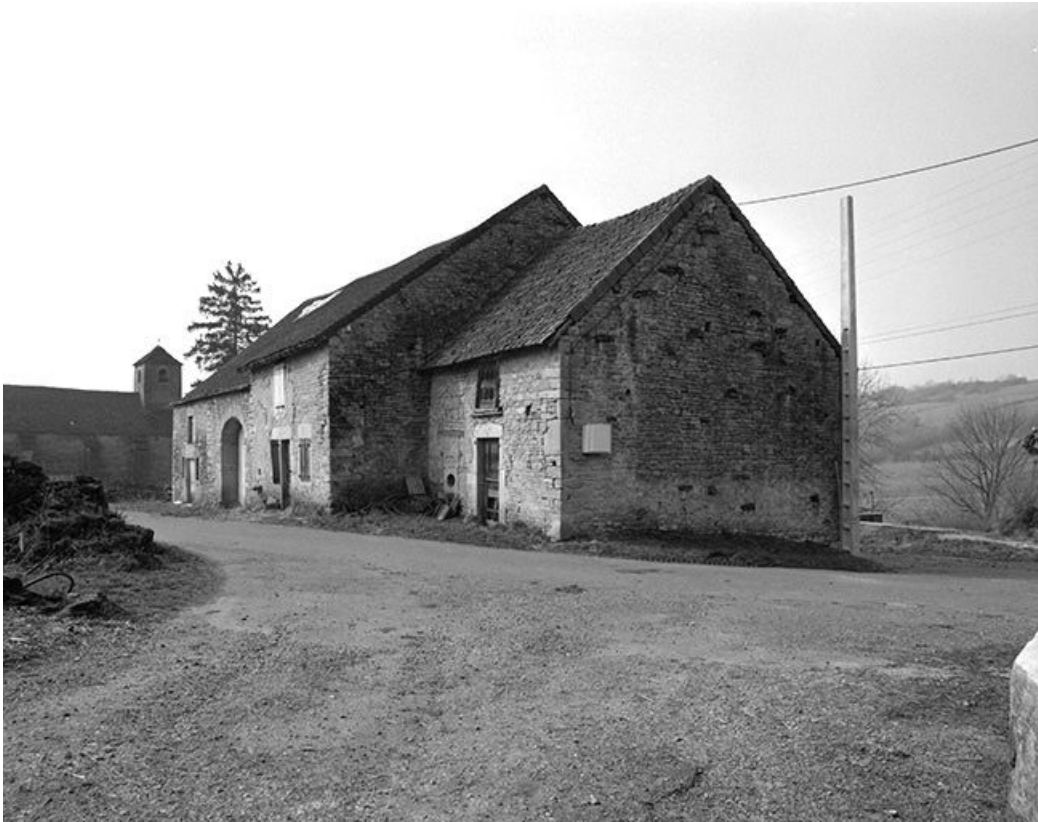
Façade antérieure et pignon droit.
