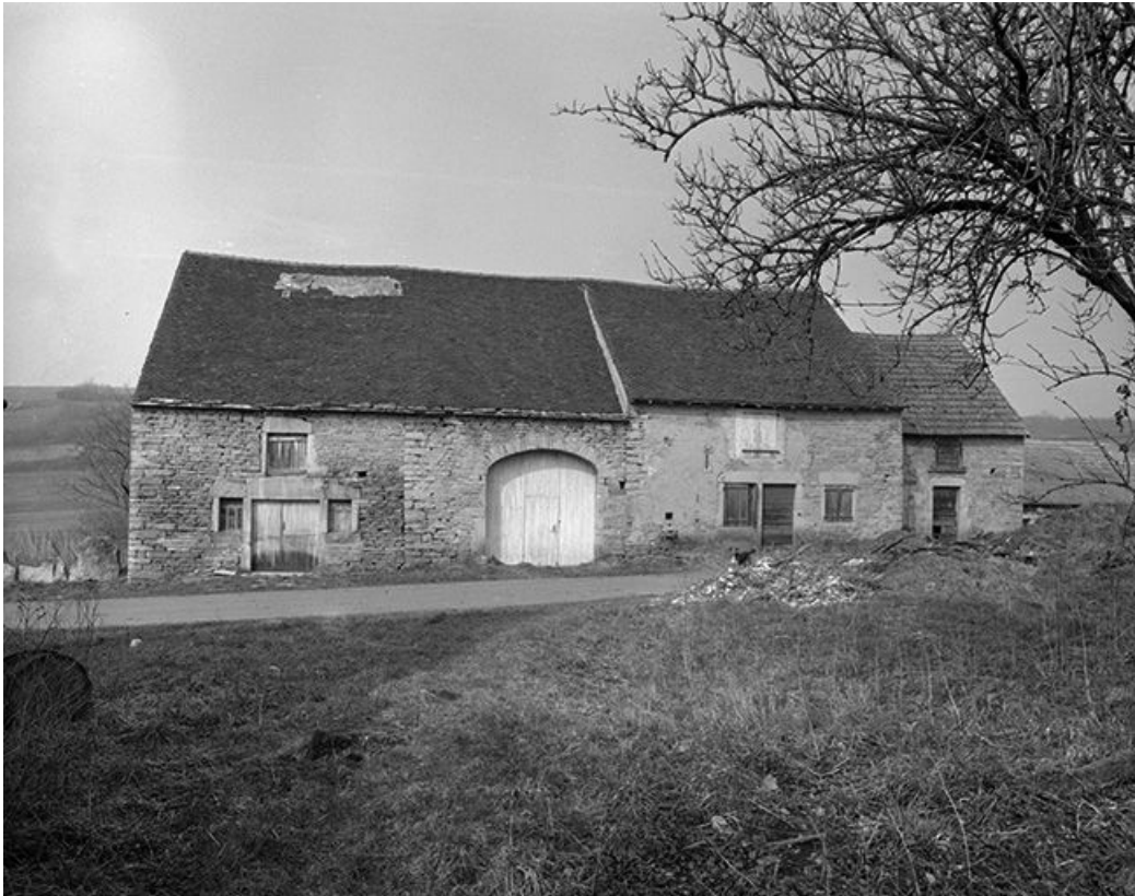
Façade antérieure, vue de face.
