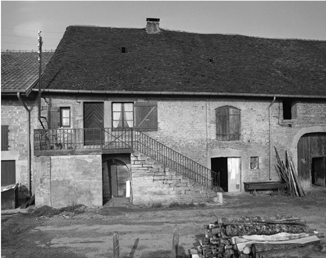
Façade antérieure : l'habitation.
