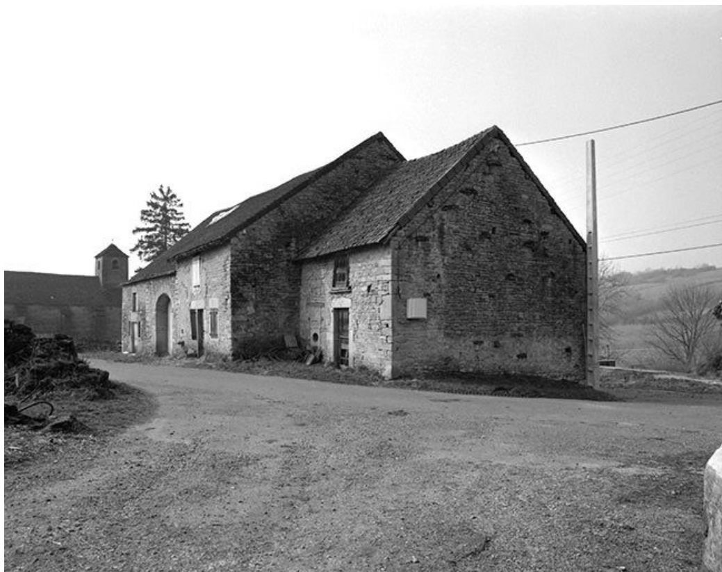
Façade antérieure et pignon droit.
