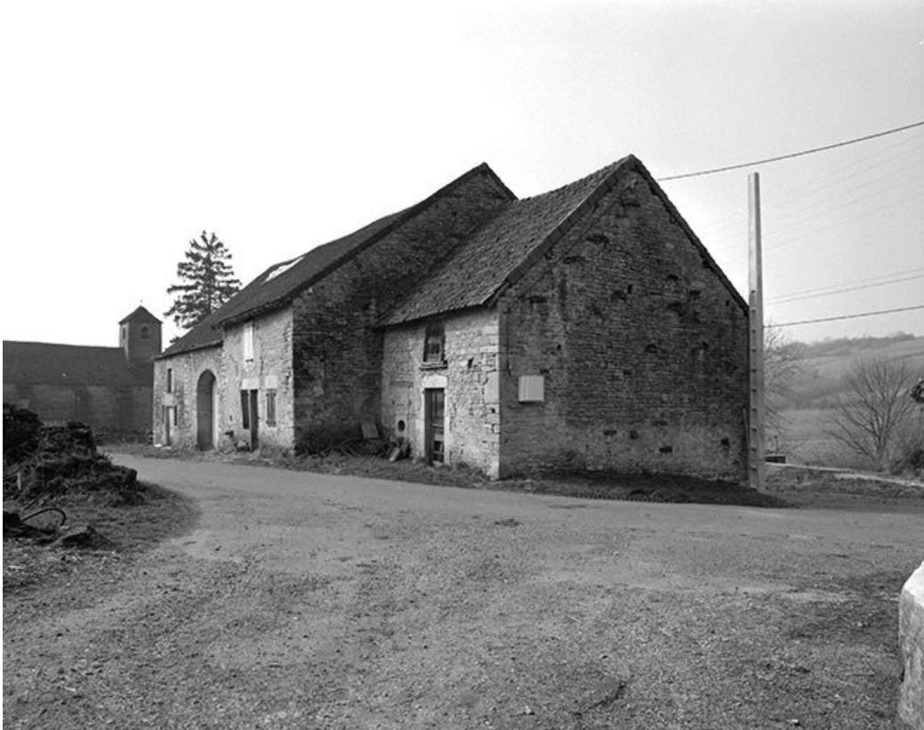
Façade antérieure et pignon droit.
