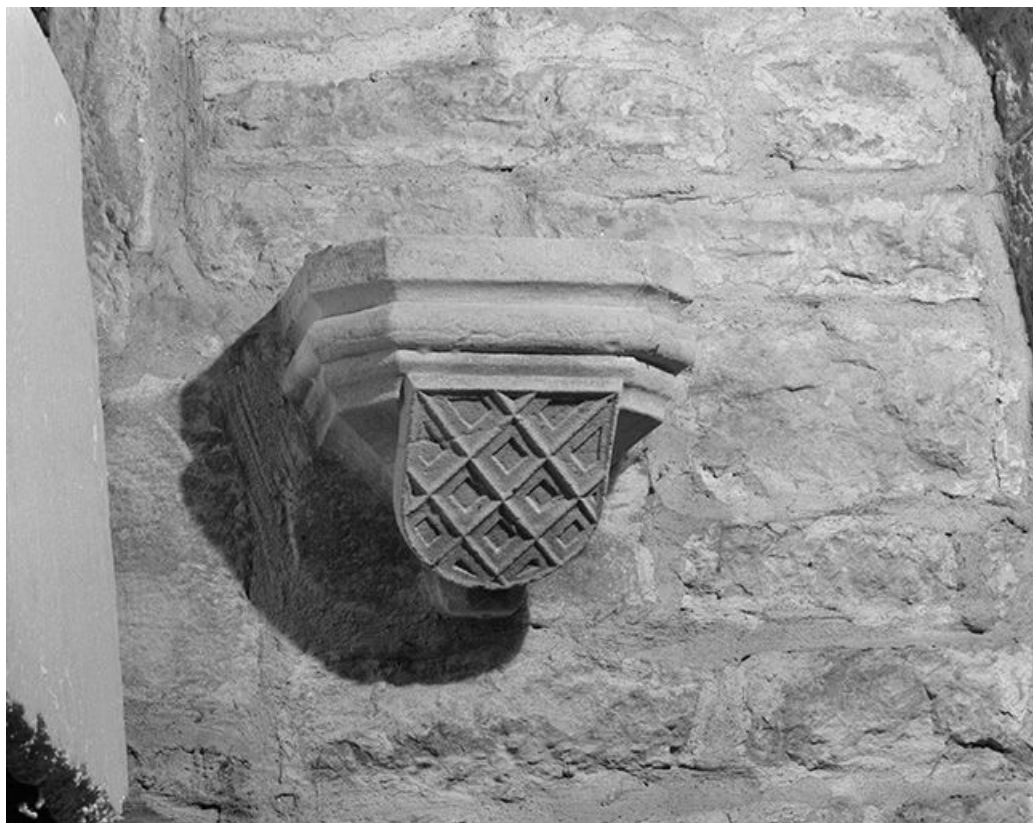
Intérieur : chapelle, mur est, console droite.
