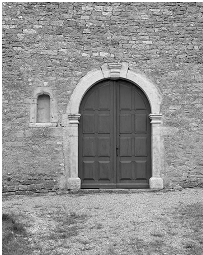
Portail de la façade antérieure.
