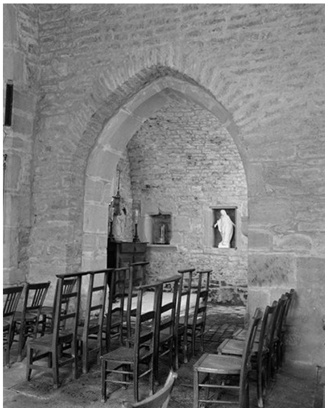
Arc d'entrée de la chapelle latérale.
