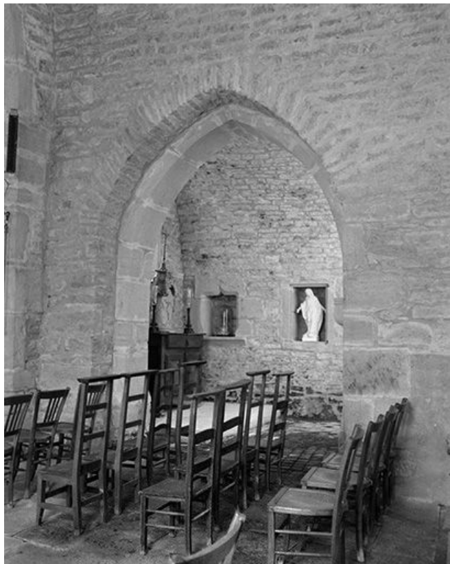
Arc d'entrée de la chapelle latérale.
