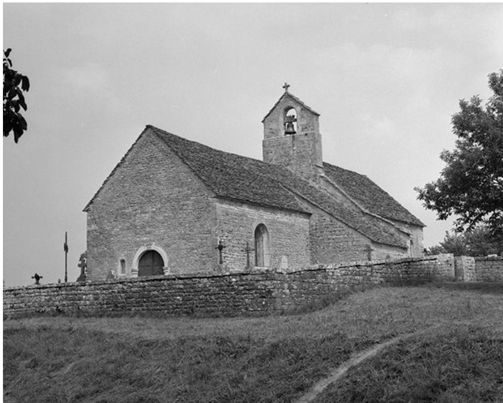
Façade antérieure et face droite.
