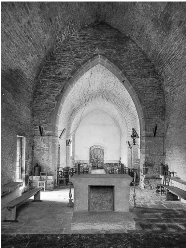
Nef vue depuis le chœur.
