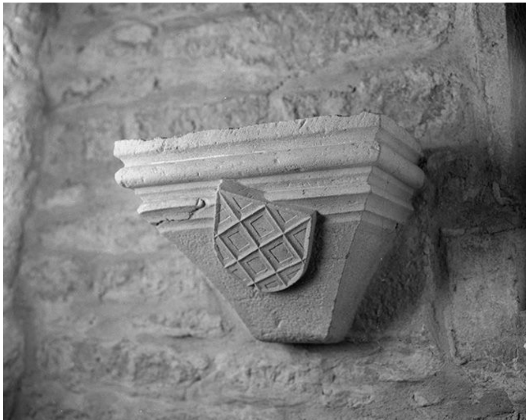
Intérieur : chapelle, mur est, console gauche.
