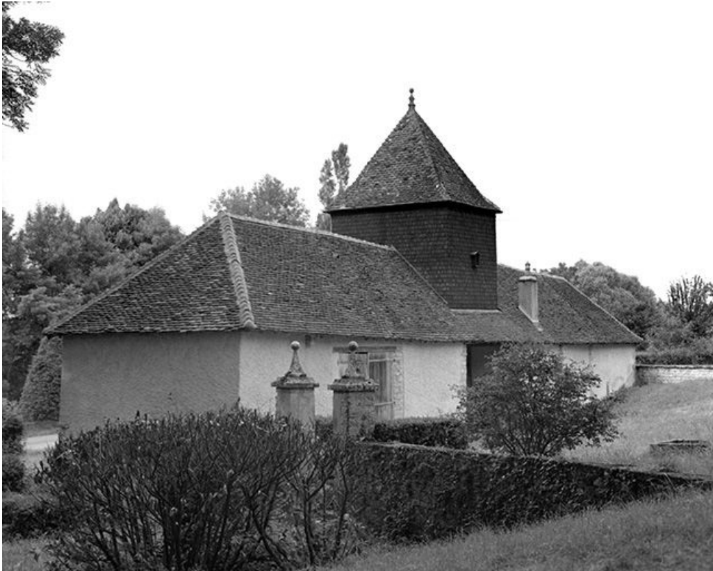
Les communs : façade postérieure vue de trois-quarts.
