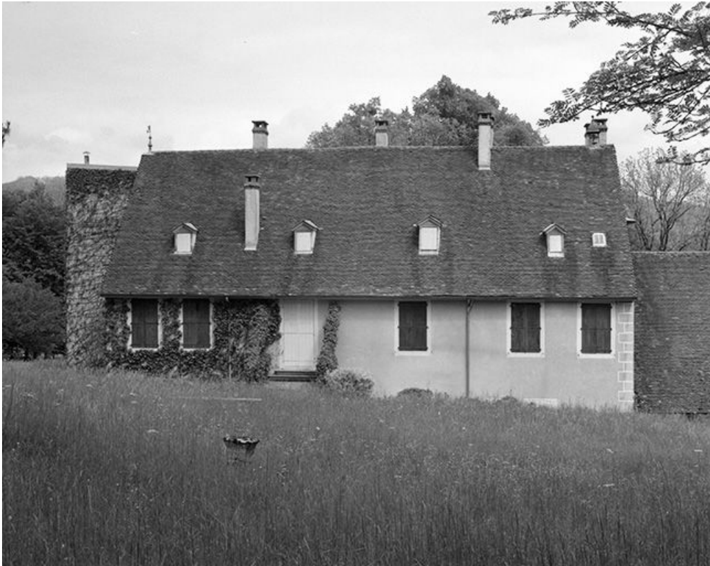
Face postérieure du logis.
