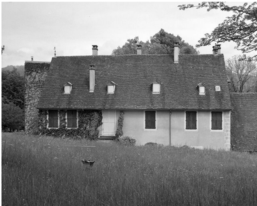
Face postérieure du logis.
