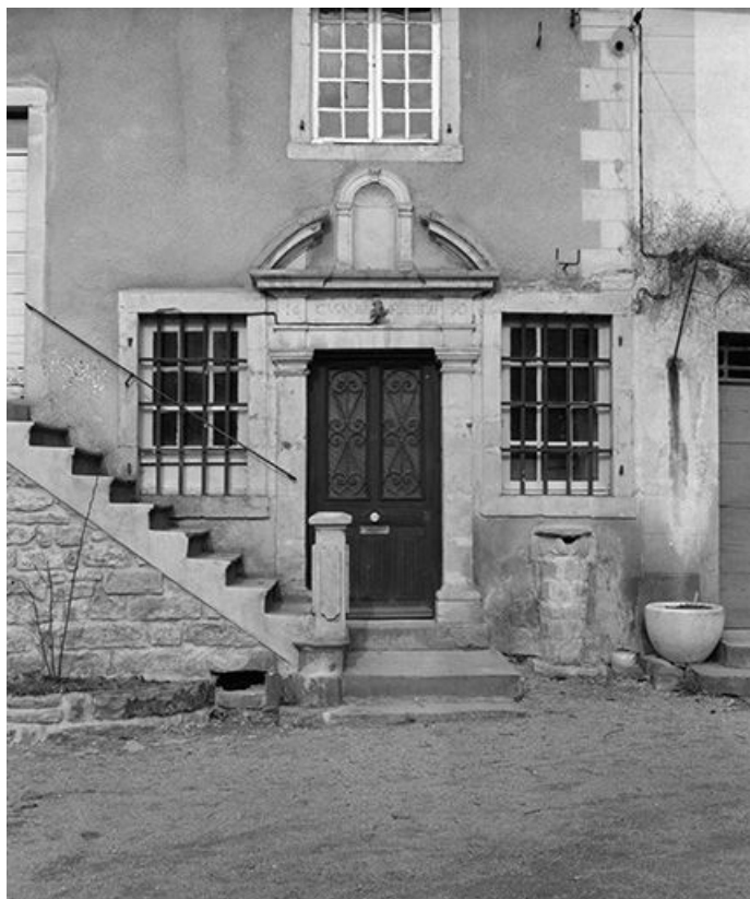
Façade antérieure, détail du rez-de-chaussée.
