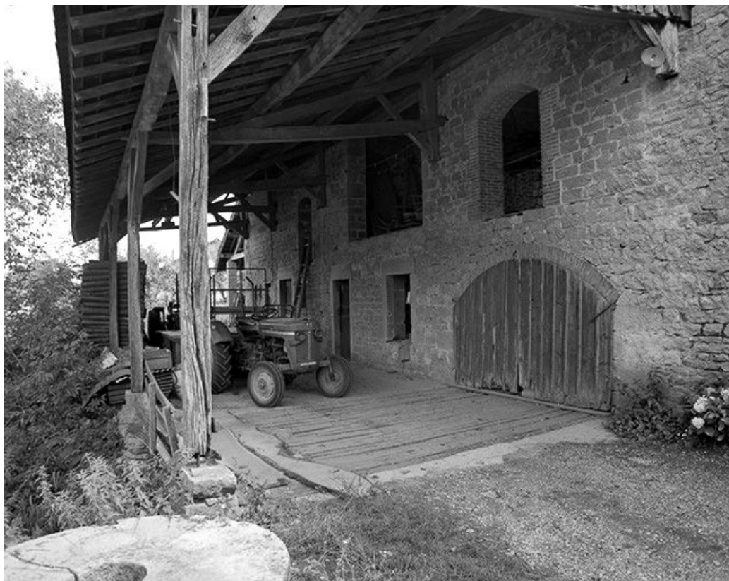
Façade antérieure, partie gauche.
