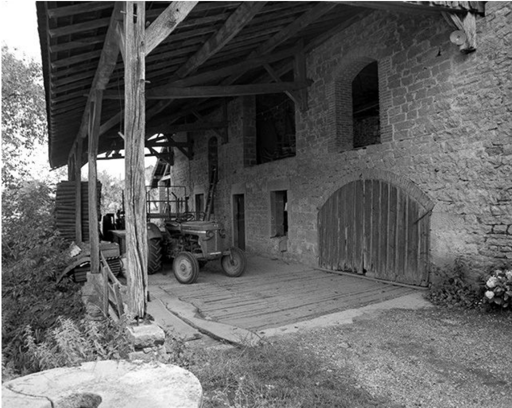
Façade antérieure, partie gauche.
