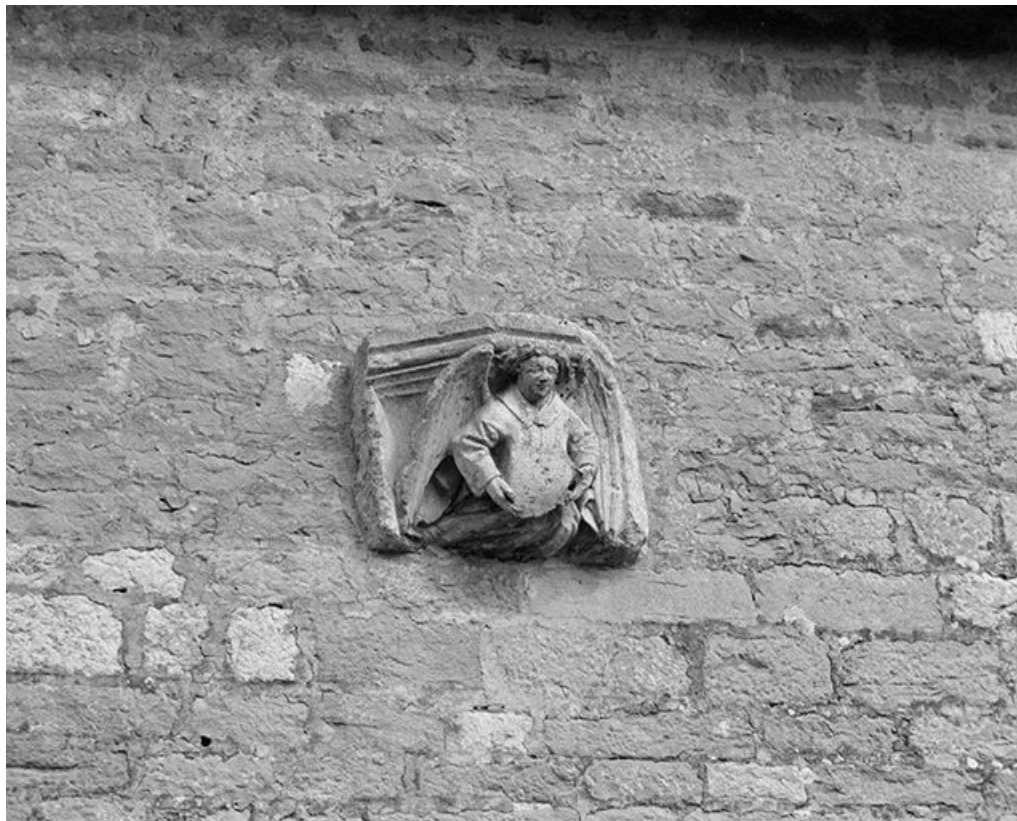
Façade antérieure : console droite.
