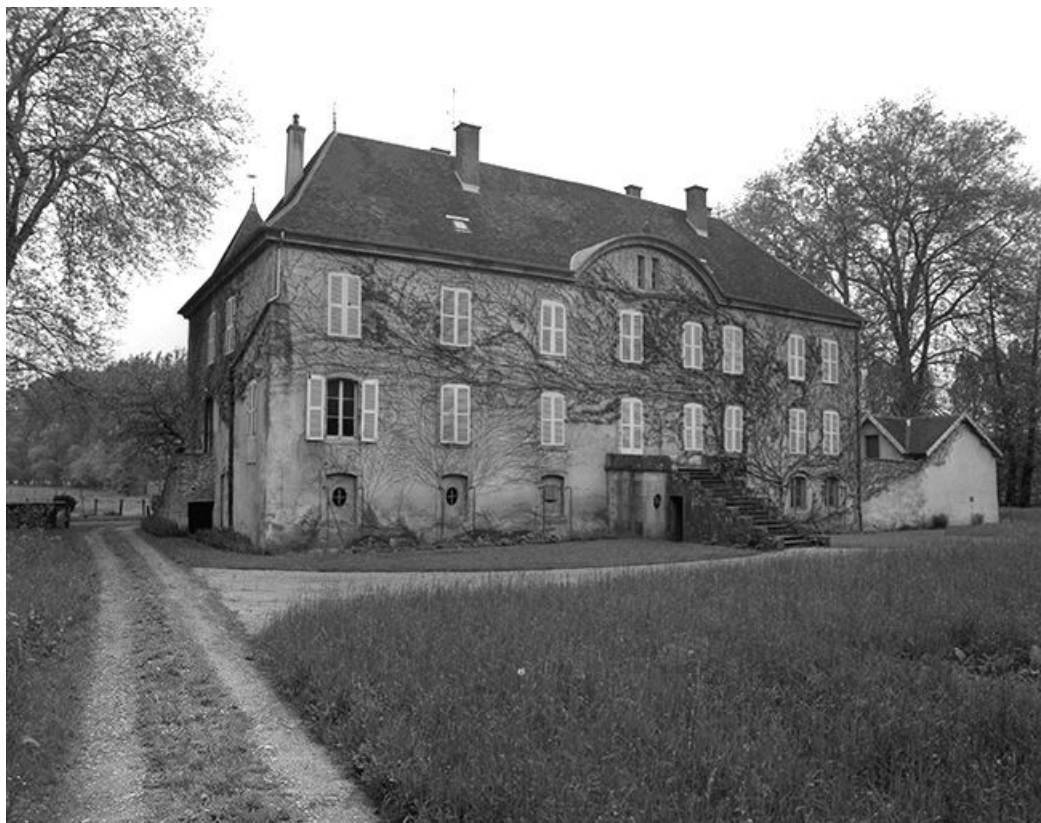
Façade principale, vue de trois quarts.
