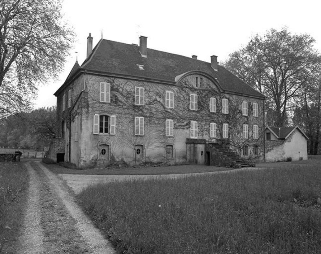
Façade principale, vue de trois quarts.
