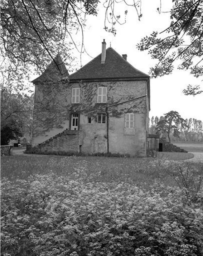
Façade latérale gauche.
