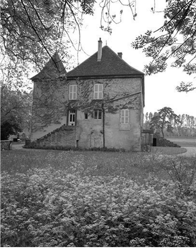
Façade latérale gauche.
