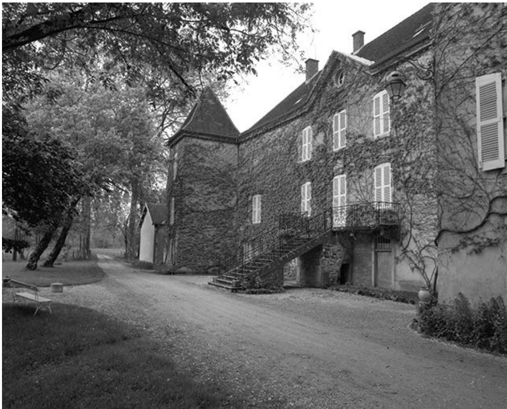
Façade antérieure, partie gauche vue de trois quarts.
