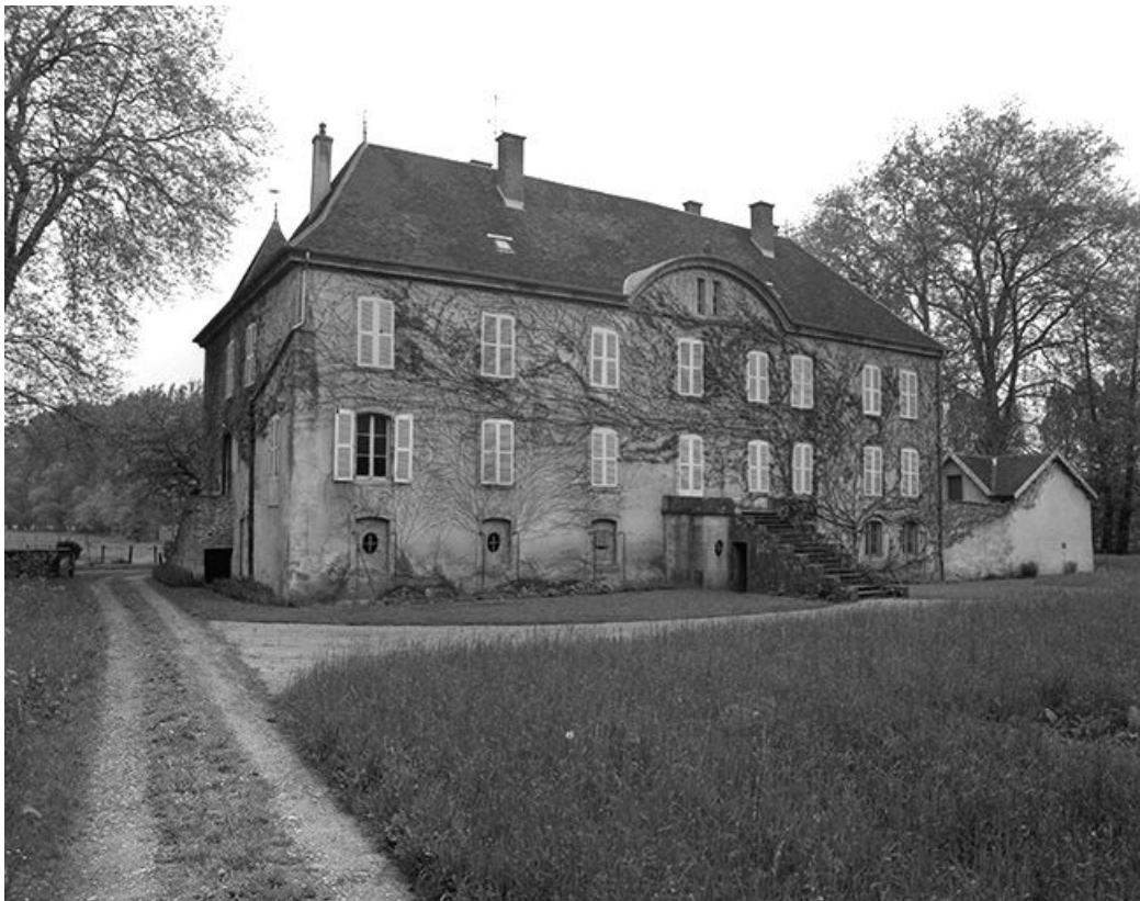
Façade principale, vue de trois quarts.
