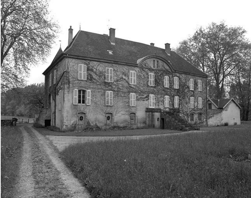
Façade principale, vue de trois quarts.
