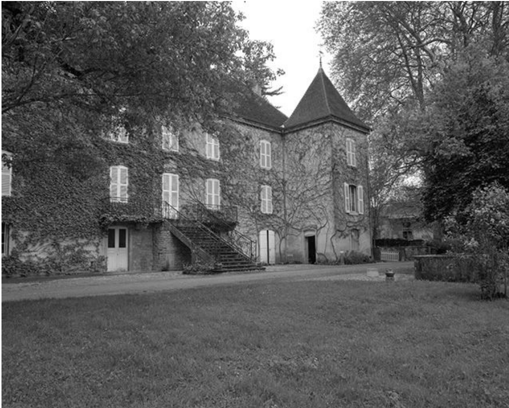
Façade antérieure, partie droite vue de trois quarts.
