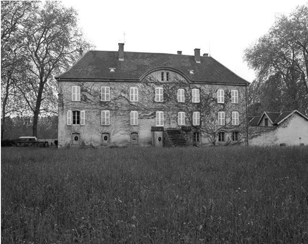
Façade antérieure, vue de face.
