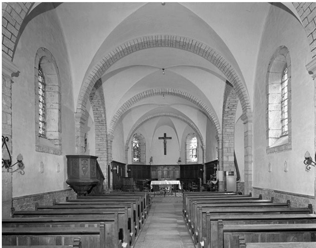
Nef vue depuis l'entrée.
