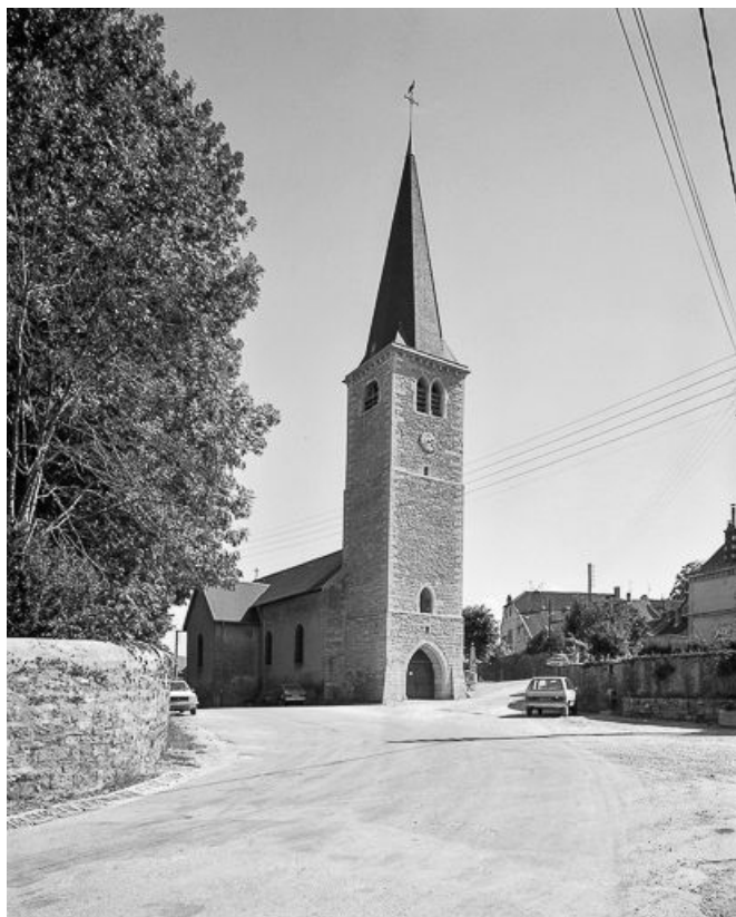
Façades antérieure et latérale gauche.
