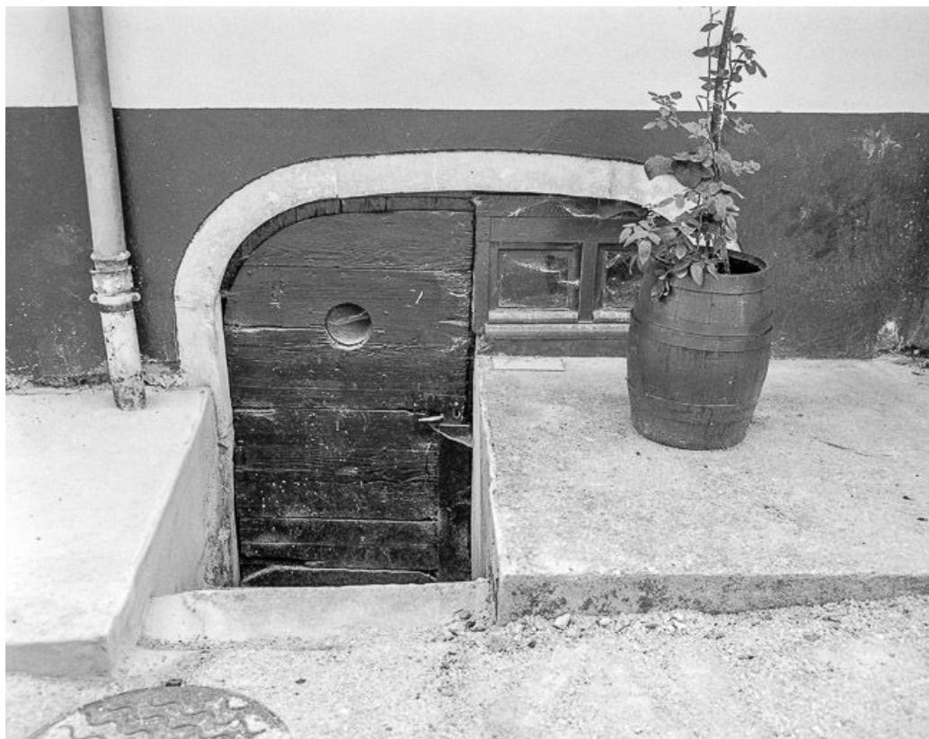
Maison : entrée de la cave.
