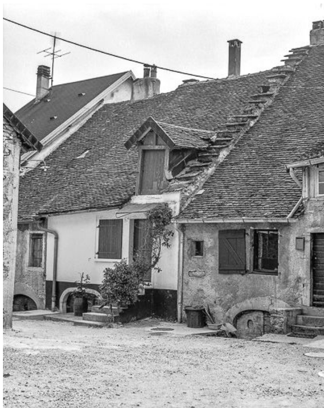
Maison : façade antérieure.
