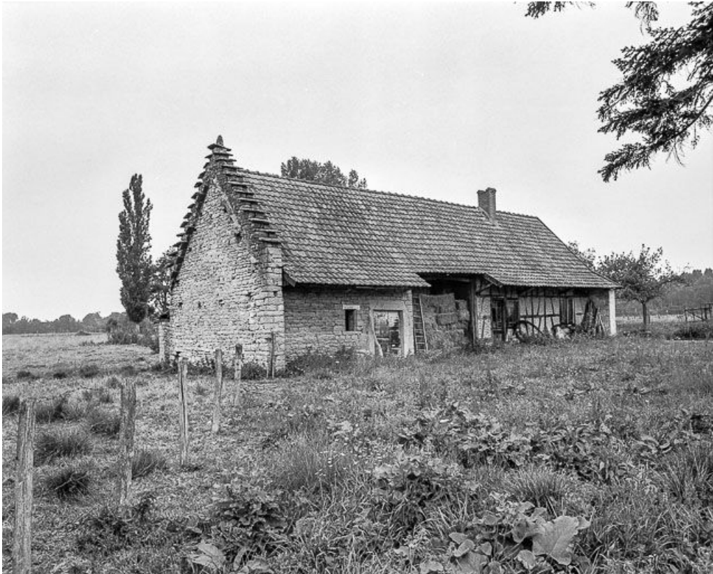
Façade antérieure et pignon gauche.
