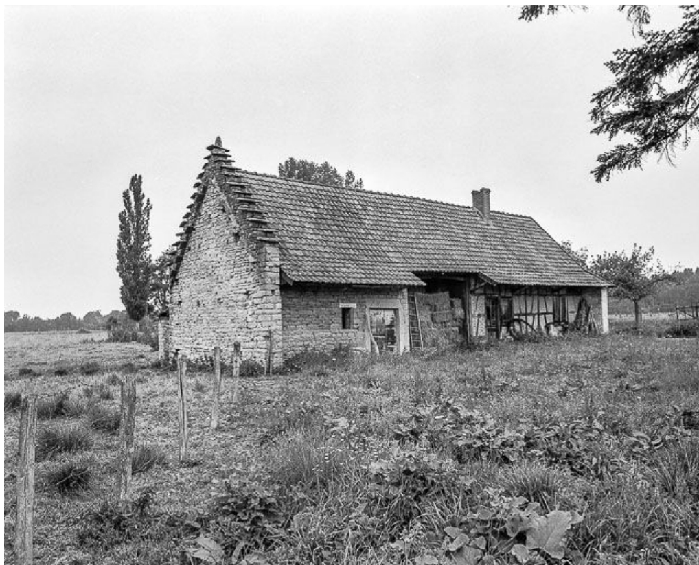
Façade antérieure et pignon gauche.
