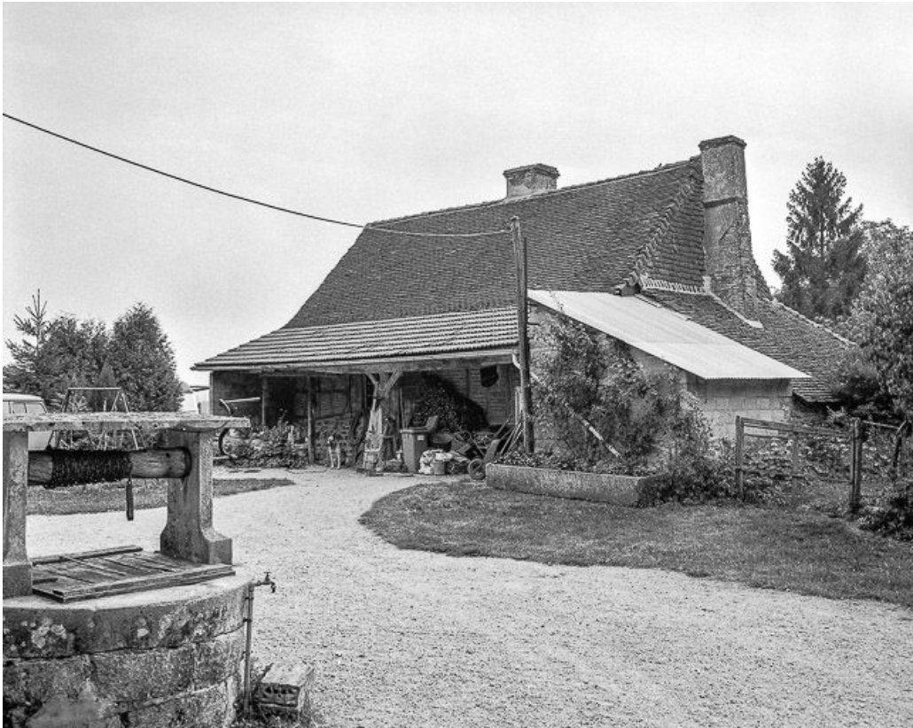
Le bâtiment à gauche de la cour.
