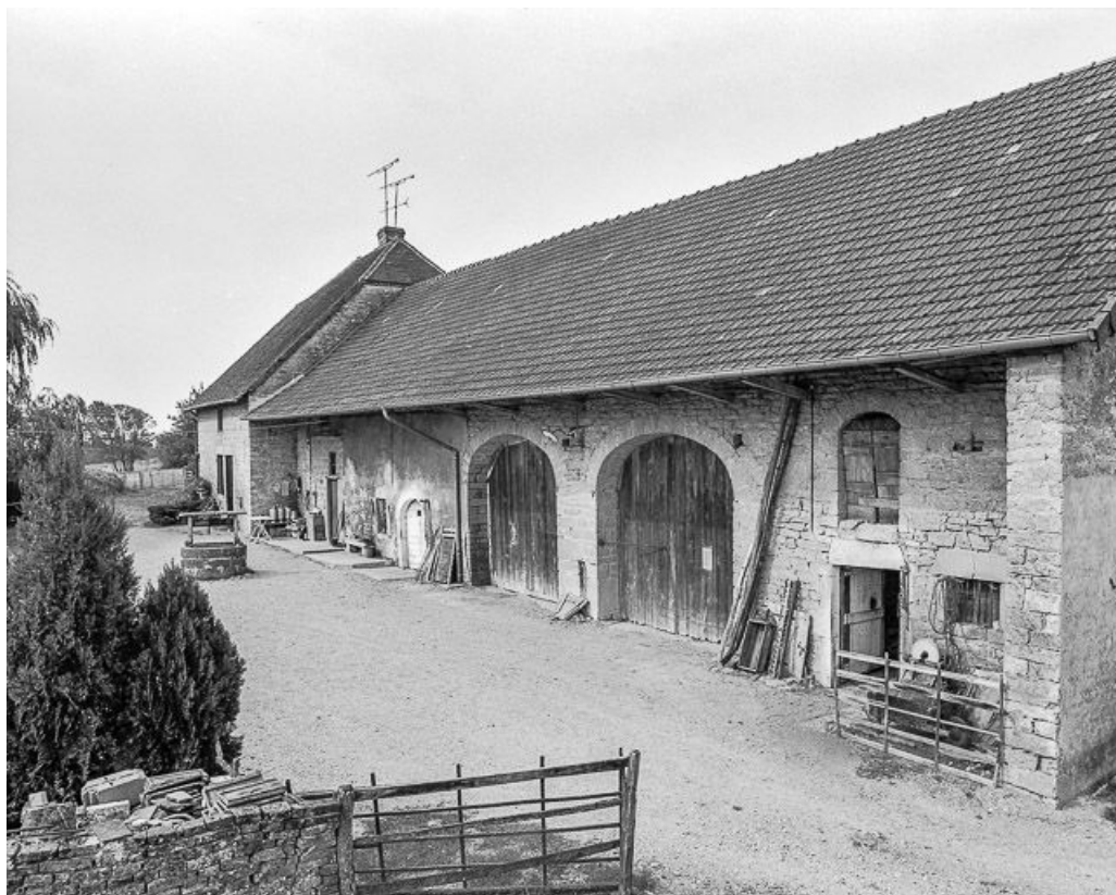
Le bâtiment à droite de la cour.
