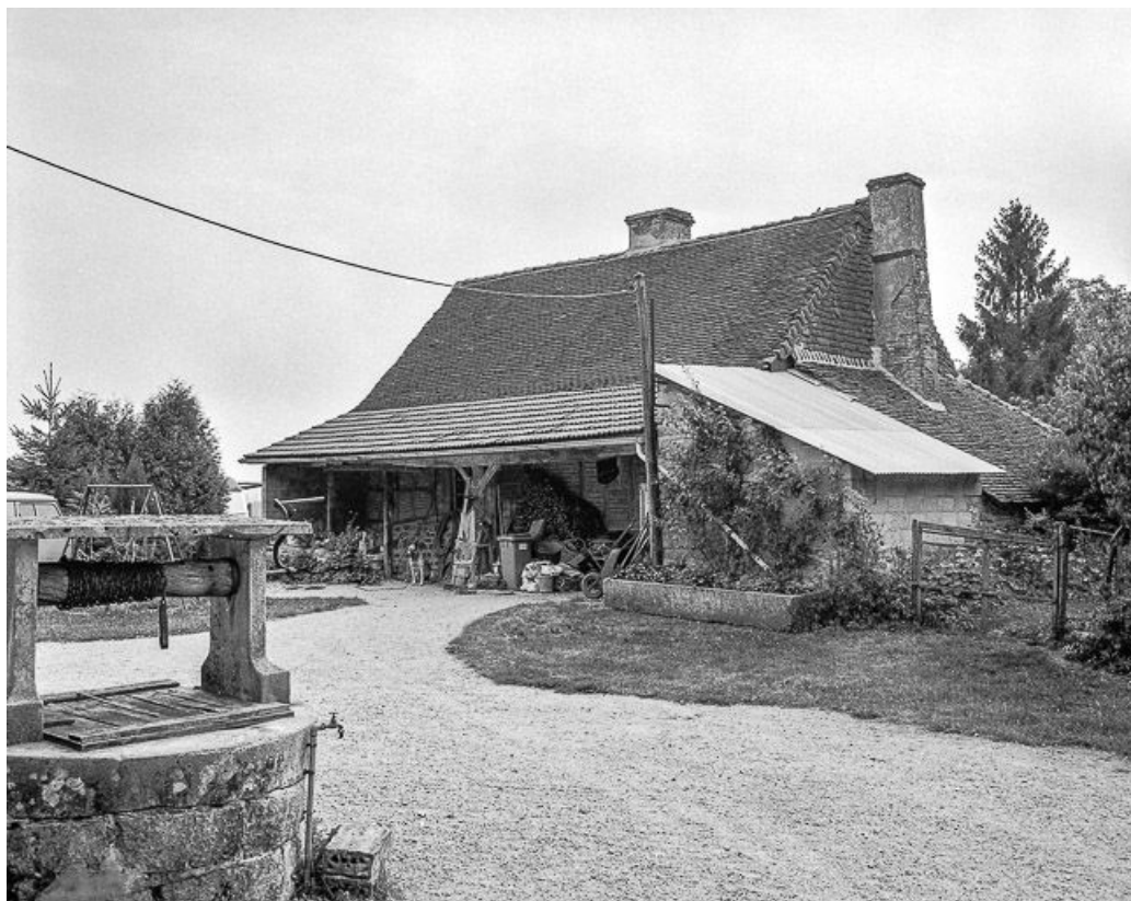
Le bâtiment à gauche de la cour.
