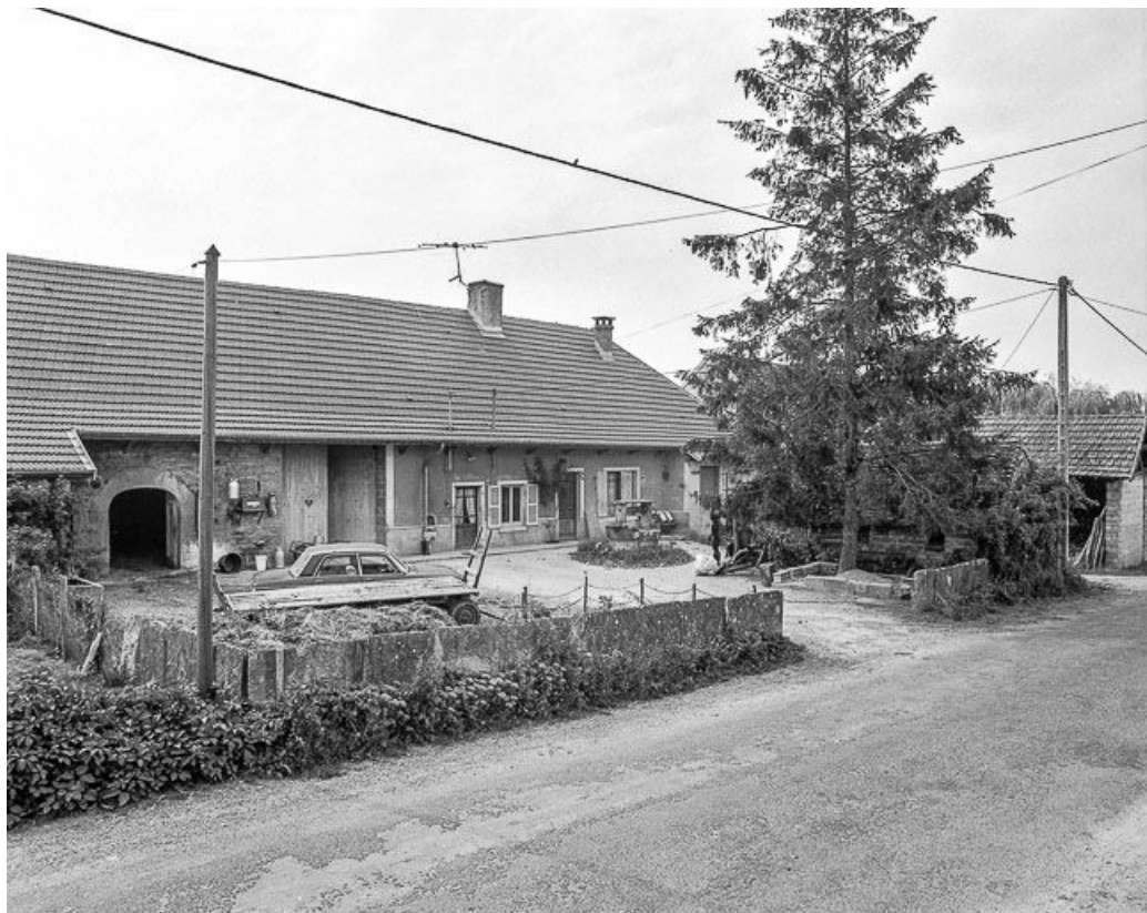
Ferme située rue du Centre, cadastrée 1945 B 317 : façade antérieure.
