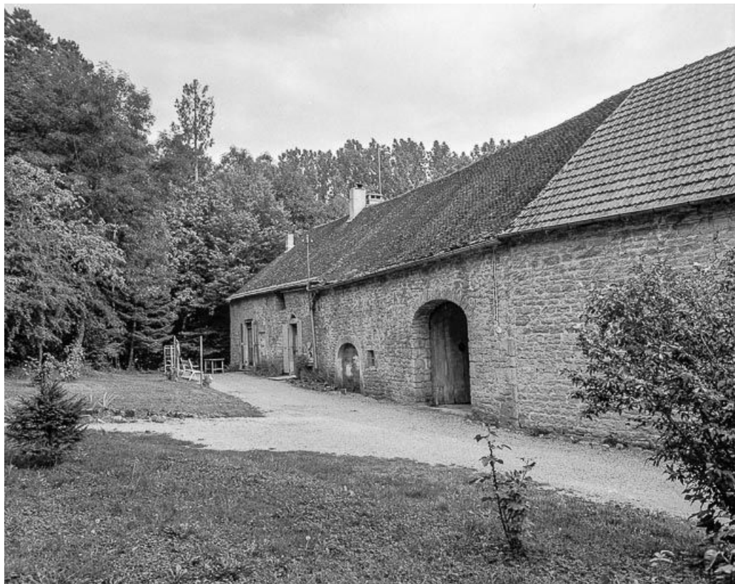
Façade sur cour.
