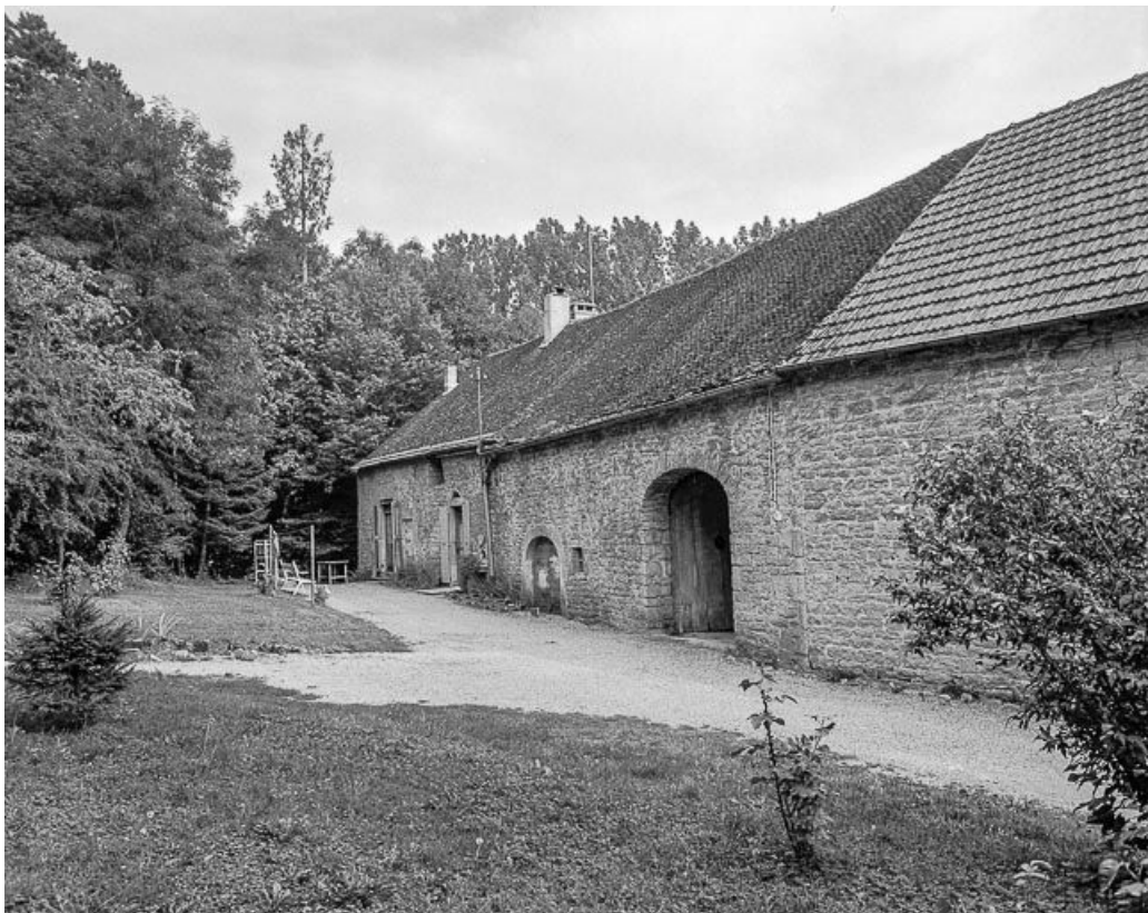
Façade sur cour.
