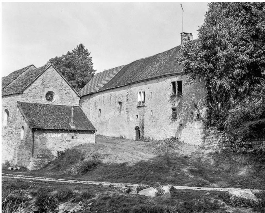
Façade côté église.
