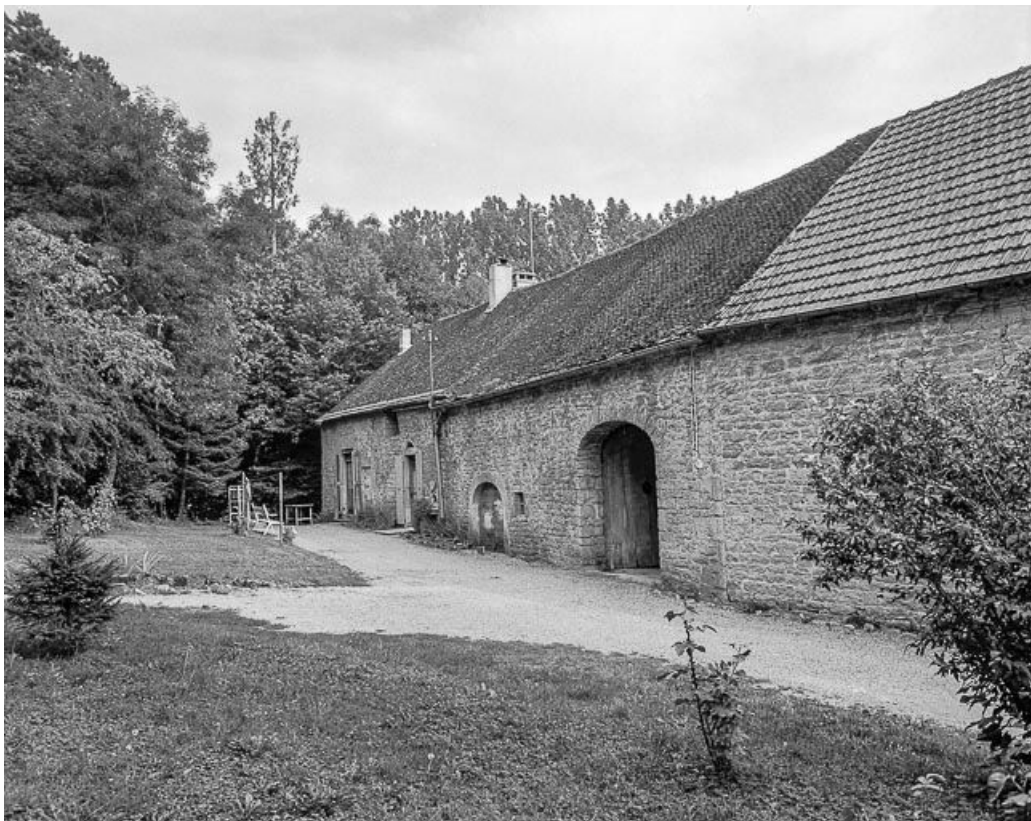
Façade sur cour.
