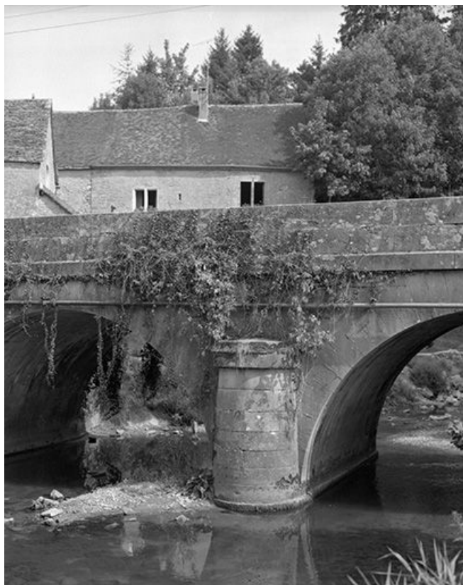
Face aval : la pile.
