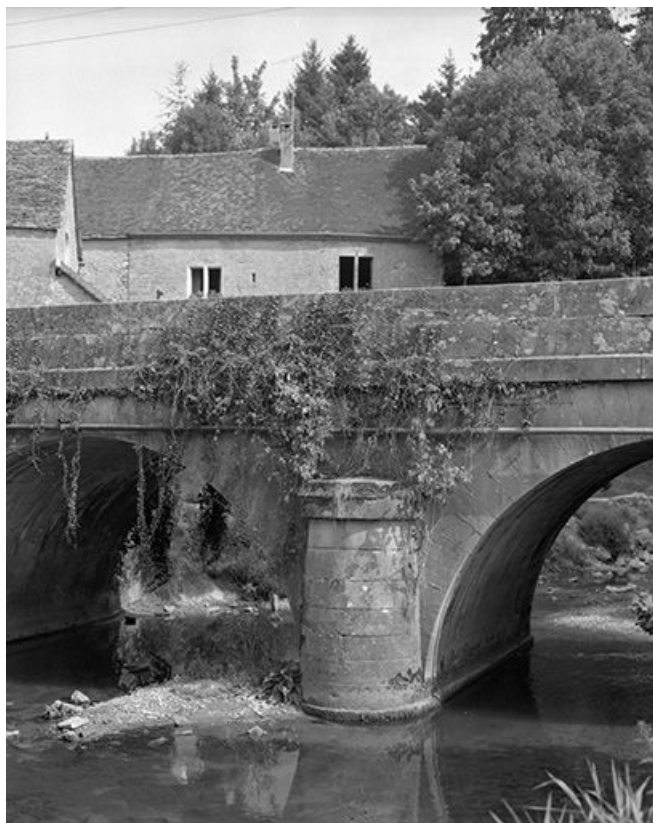
Face aval : la pile.
