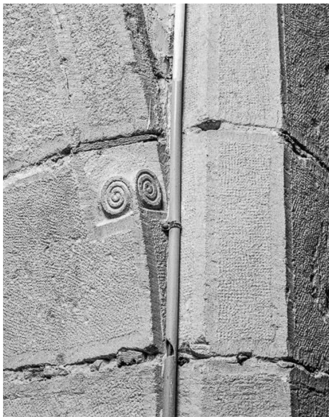
Première chapelle droite : détail du congé à droite de l'arc d'entrée. 39, Chilly-le-Vignoble rue de l' Eglise
