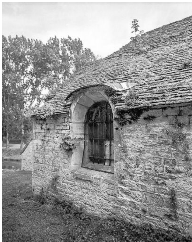
Baie de la 2e chapelle sur la façade latérale gauche.
