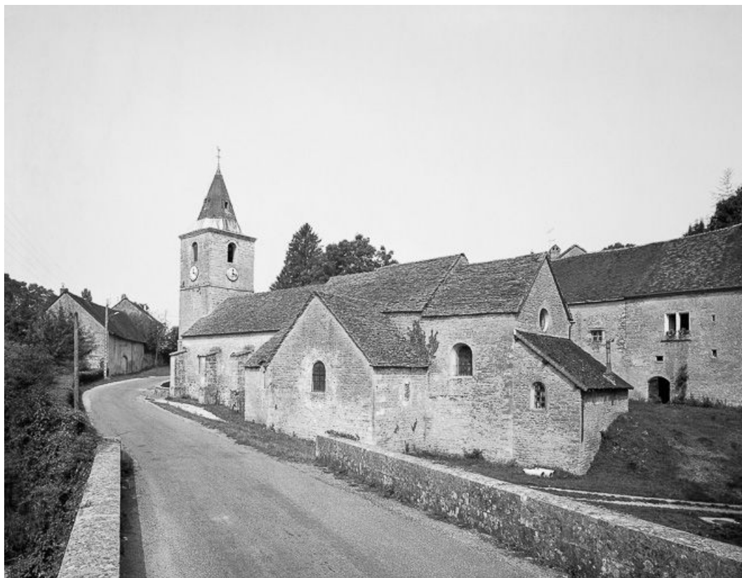
Façade latérale droite, chevet et clocher.
