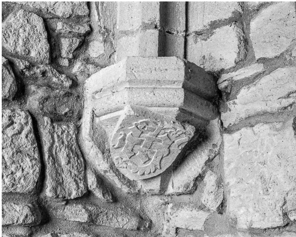
Première chapelle droite : culot sud-ouest.
