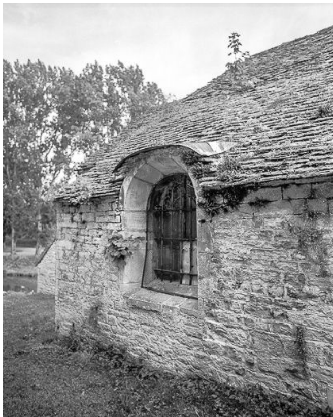
Baie de la 2e chapelle sur la façade latérale gauche.
