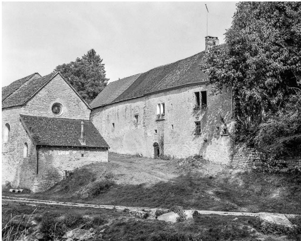
Façade côté église.
