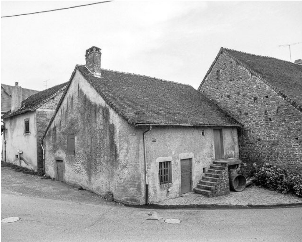
Façades antérieure et latérale gauche.
