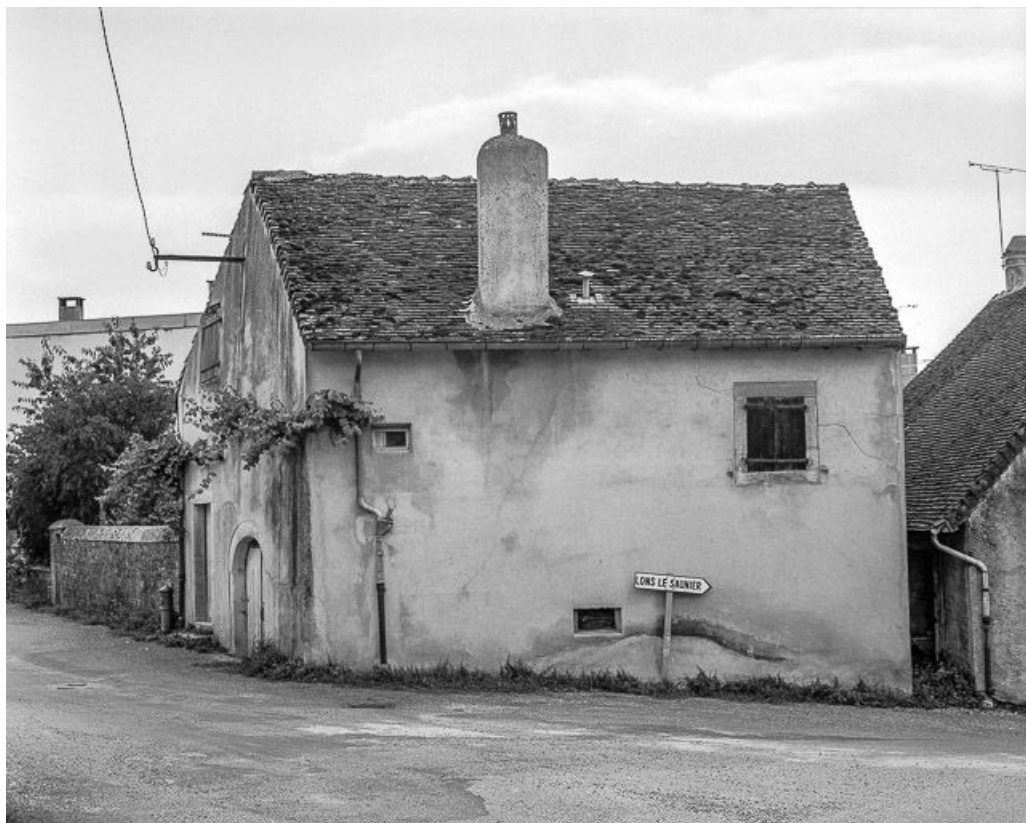
Façade latérale gauche.
