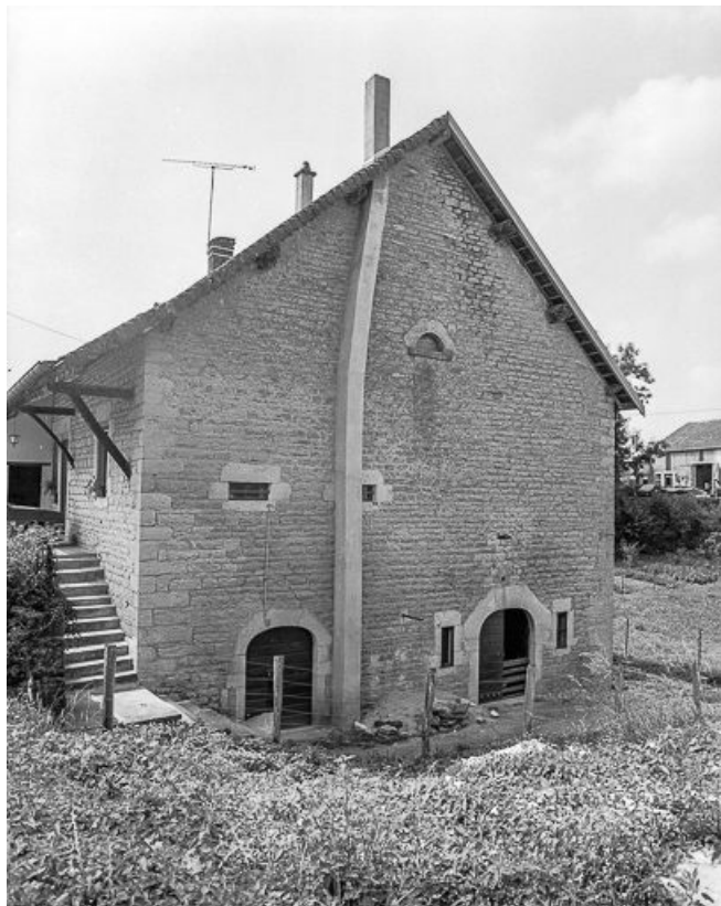
Façade latérale droite.
