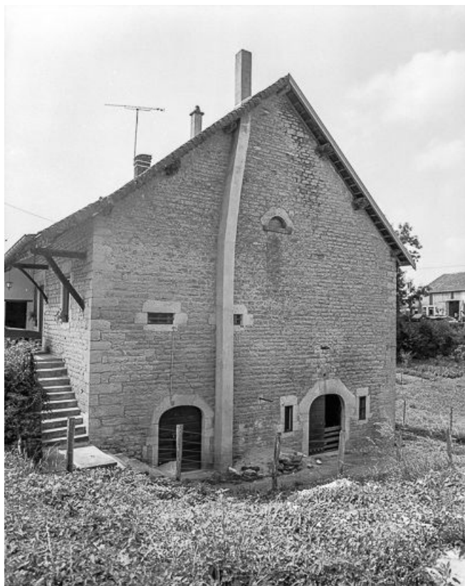
Façade latérale droite.
