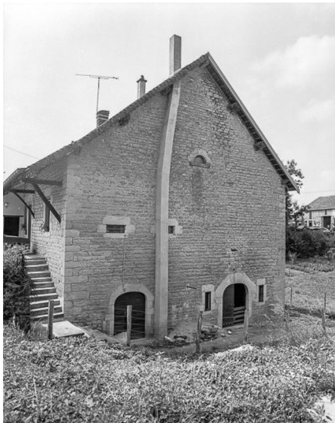
Façade latérale droite.
