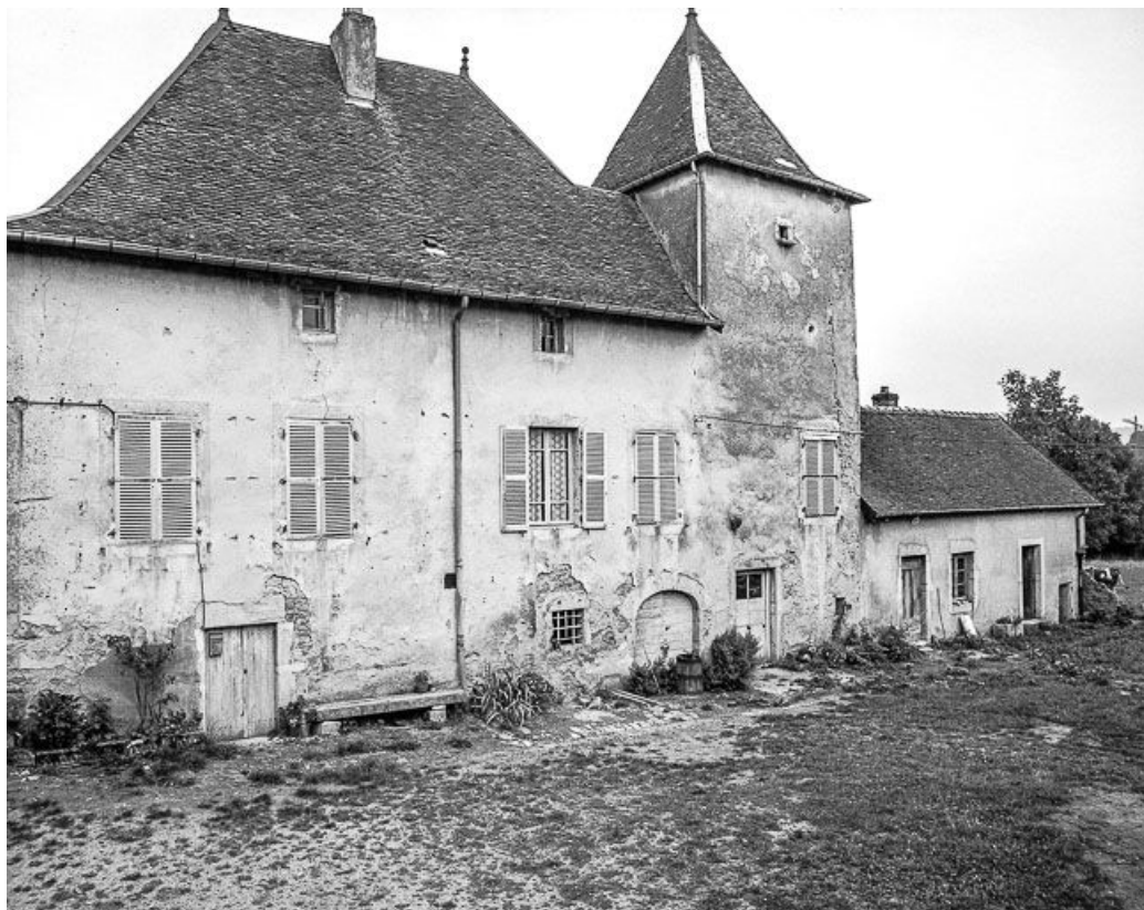
Le logis : façade sur cour.
