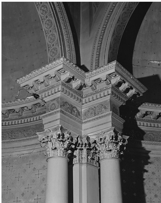
Chapelle II, détail de l'entablement du chœur.
