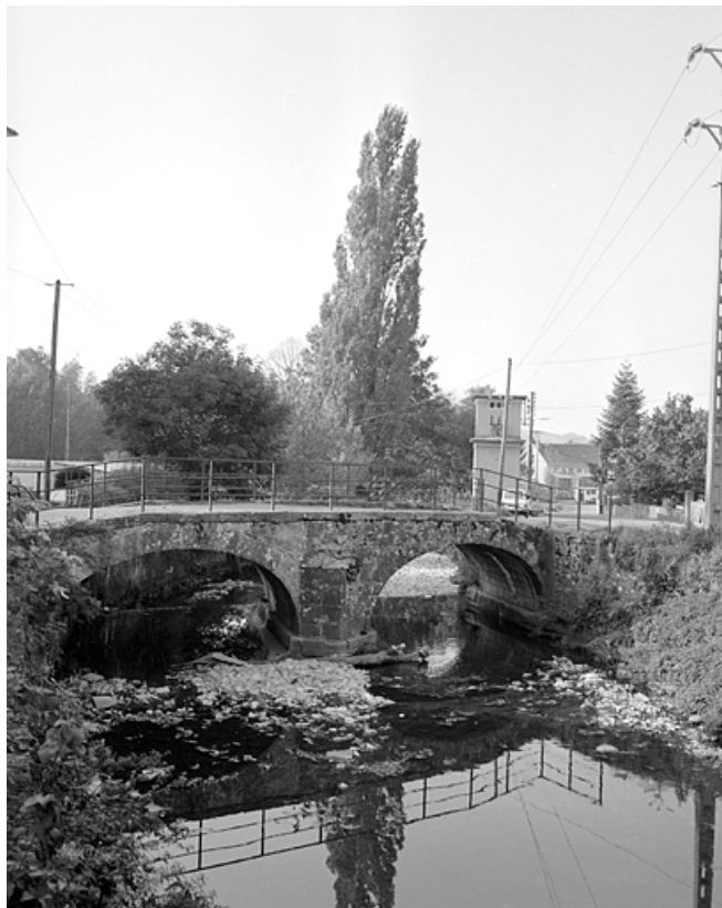
Vue du pont en amont.
