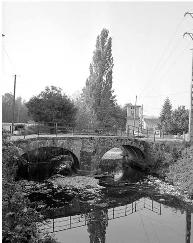
Vue du pont en amont.
