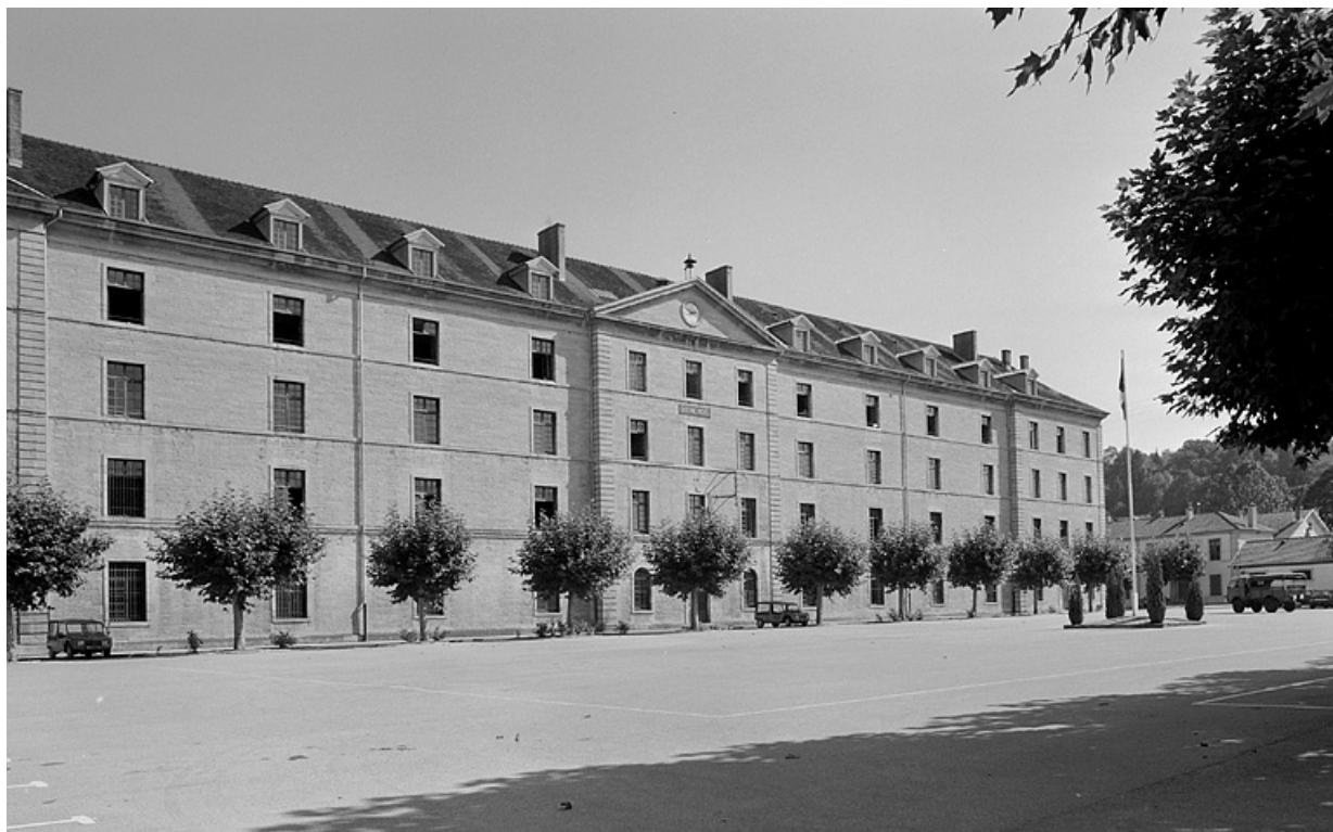
Façade antérieure, partie droite.
