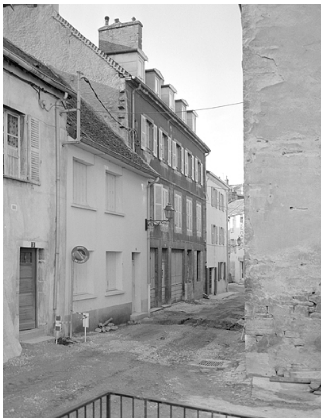
Façade antérieure du corps de bâtiment donnant sur la rue de l'Agriculture. 39, Lons-le-Saunier, 18 rue Sébile
