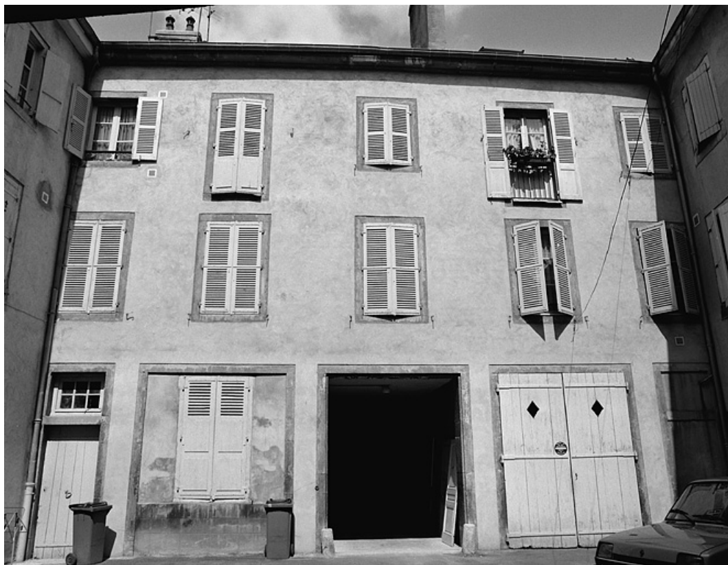
Façade sur cour du corps de bâtiment donnant sur la rue de l'Agriculture.
