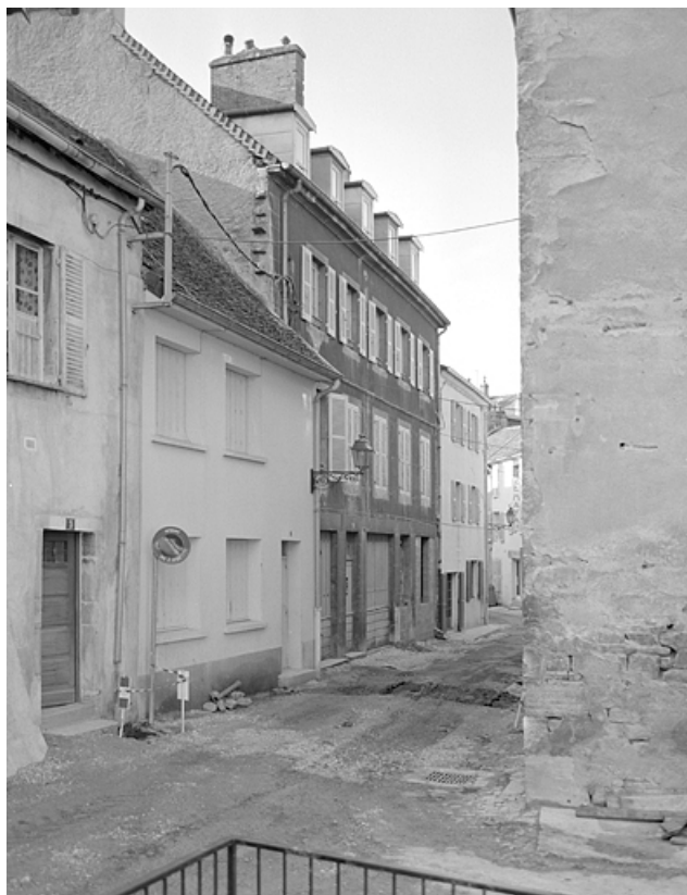
Façade antérieure du corps de bâtiment donnant sur la rue de l'Agriculture. 39, Lons-le-Saunier, 18 rue Sébile
