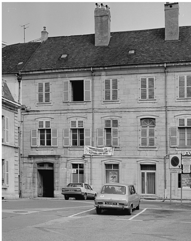
Façade antérieure, partie gauche.
