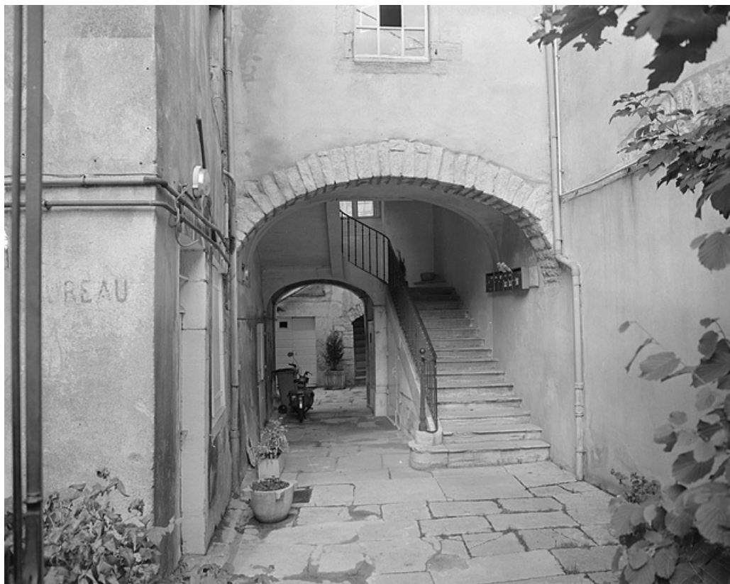
Escalier formant passage d'accès à la cour.
