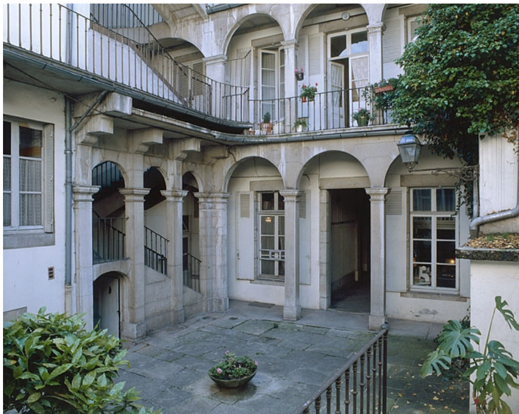
Façade sur la cour, détail.
