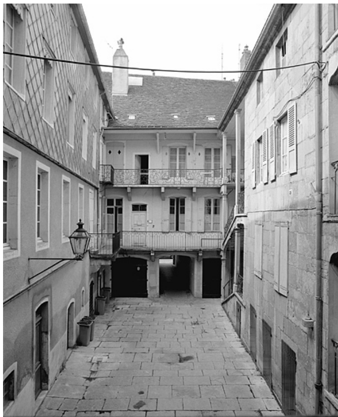
Vue de la cour et de la façade postérieure.
