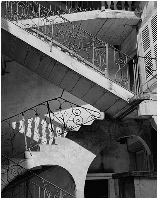
Escalier dans la cour, détail des rampes.
