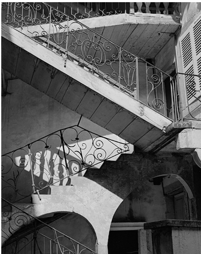
Escalier dans la cour, détail des rampes.
