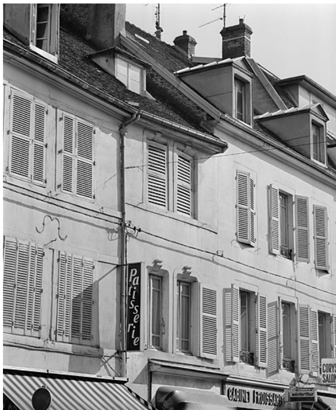
Façade antérieure, premier et deuxième étages.
