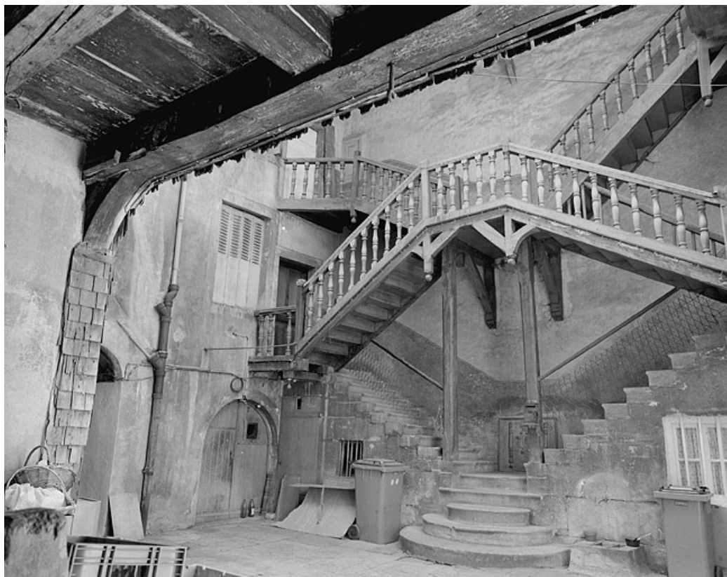
Escalier dans la cour et façade antérieure du corps de bâtiment en fond de cour.
