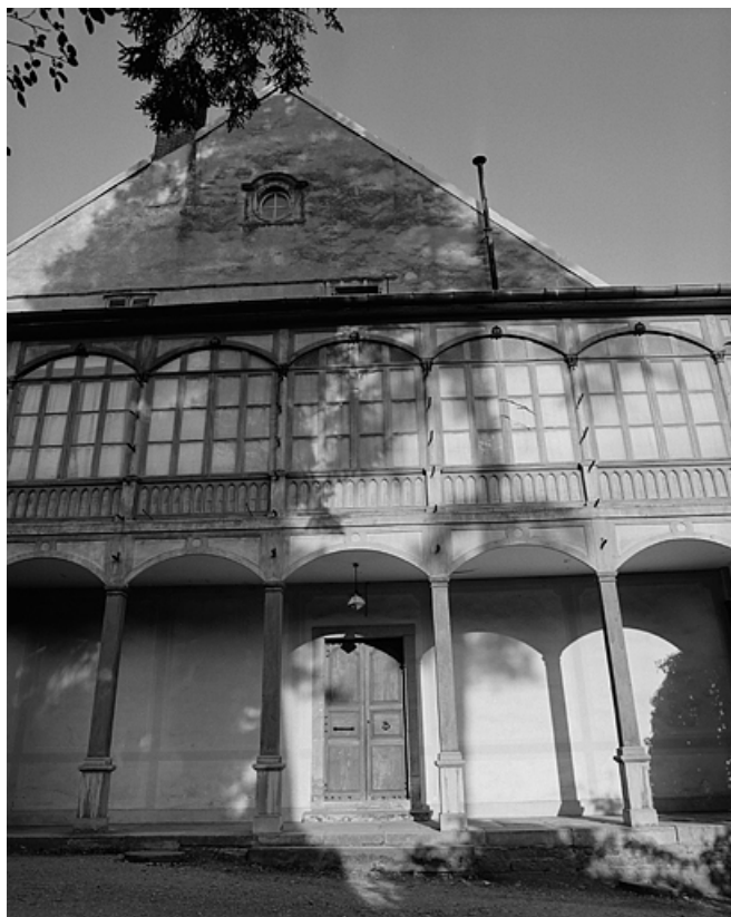
Galerie fermée sur colonnade flanquant la façade latérale.
