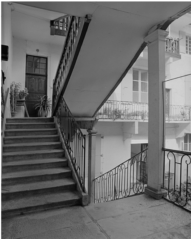
Escalier vu depuis le premier palier.
