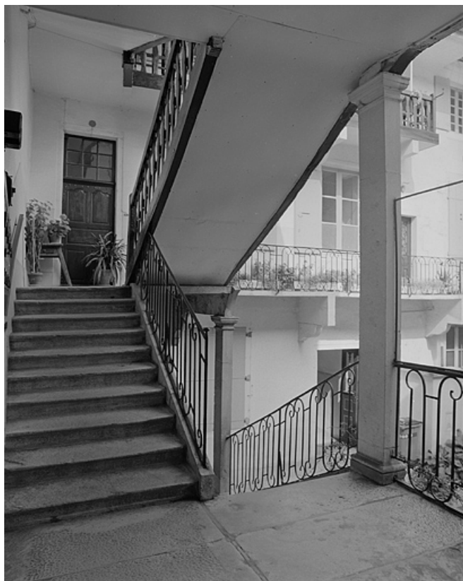
Escalier vu depuis le premier palier.
