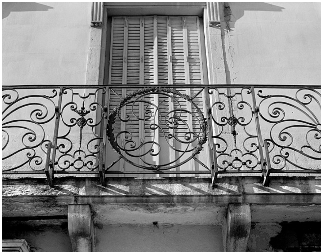
Façade antérieure, détail du balcon.
