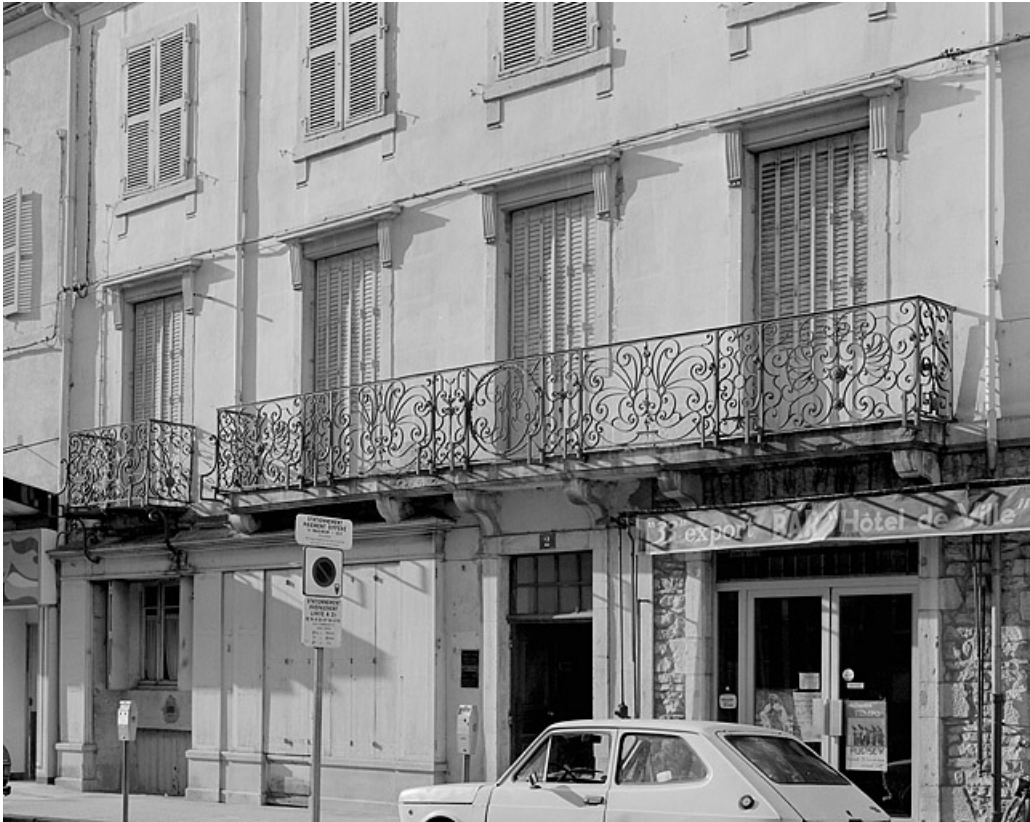
Façade antérieure, vue partielle.
